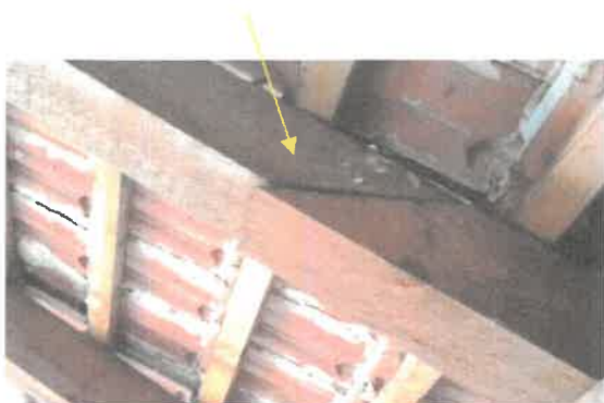
Spoj krokve lípnutím vykazuje posun o 1,5 cm!
