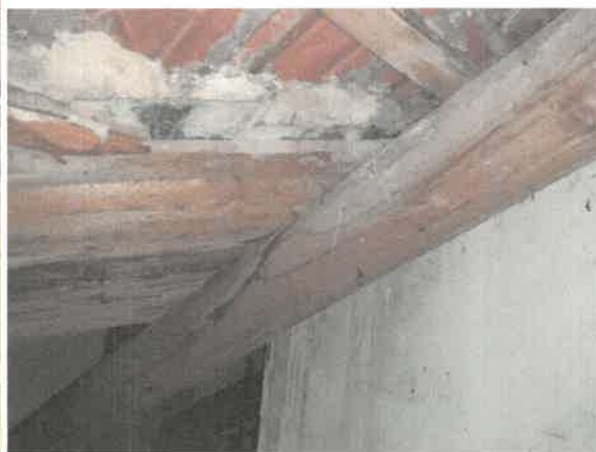
Maltové utěsnění průniku v úžlabí za štítem
