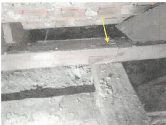
Plát okapové vaznice bez fixace hřebíky!
