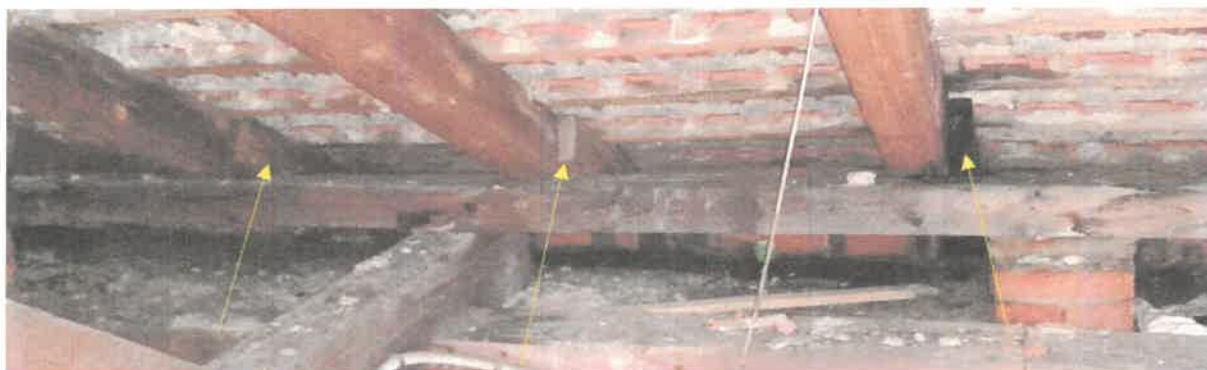
Námětky pod bedněním římsy jsou přitlučeny jednostranně a mají malý průřez!
