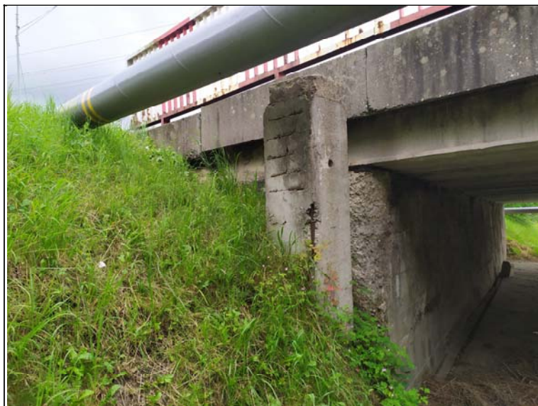
Pohled na levé křídlo opěry 2
