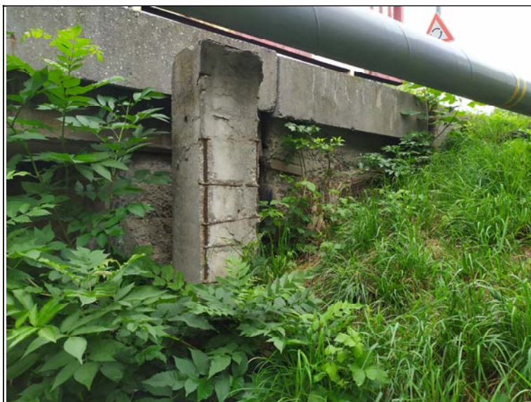
Pohled na levé křídlo opěry 1
