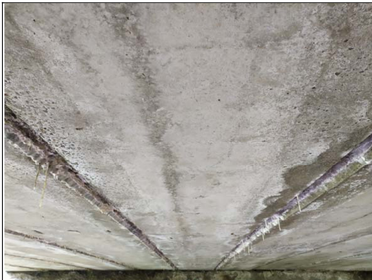
Podhled nosné konstrukce - s pohledem k opěře 1
