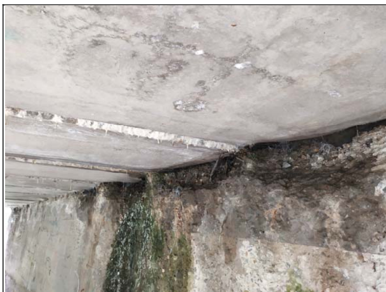
Úložný práh opěry 1
