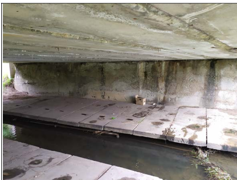
Pohled na opěru 2
