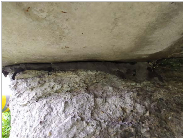
Úložný práh opěry 1
