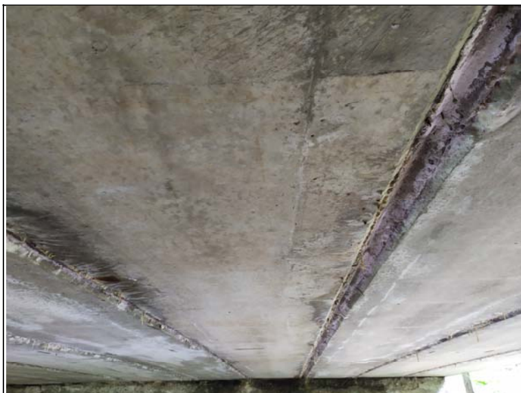
Podhled nosné konstrukce - s pohledem k opěře 1
