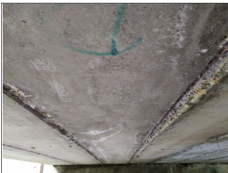
Podhled nosné konstrukce - s pohledem k opěře 2
