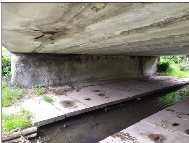
Pohled na opěru 1
