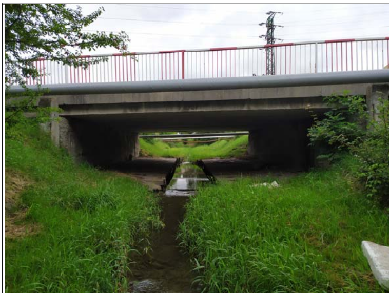
Prostorové uspořádání pod mostem (povodní)
