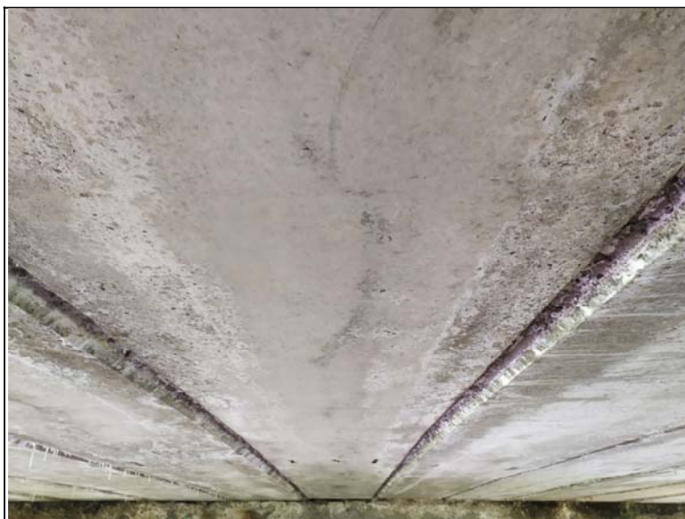
Podhled nosné konstrukce - s pohledem k opěře 1
