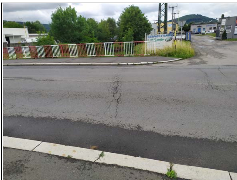
Mostní závěr nad opěrou 1
