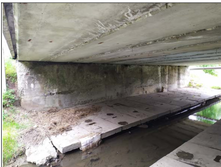
Pohled na opěru 2
