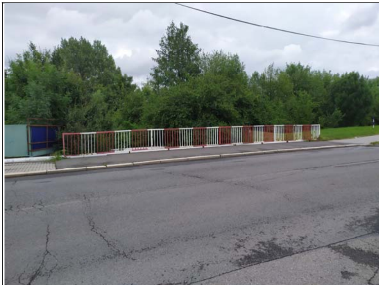
Levé zábradlí - s pohledem k opěře 2
