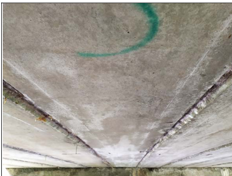
Podhled nosné konstrukce - s pohledem k opěře 2
