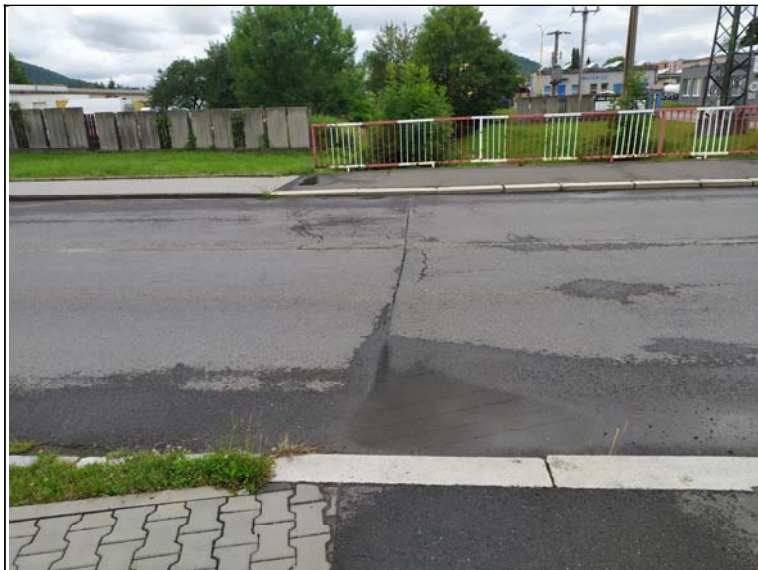
Mostní závěr nad opěrou 2
