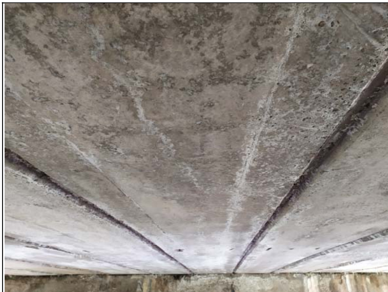
Podhled nosné konstrukce - s pohledem k opěře 2
