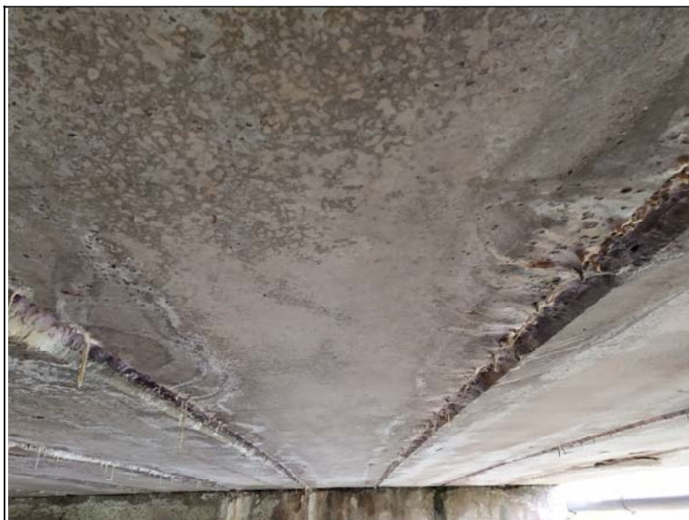
Podhled nosné konstrukce - s pohledem k opěře 2
