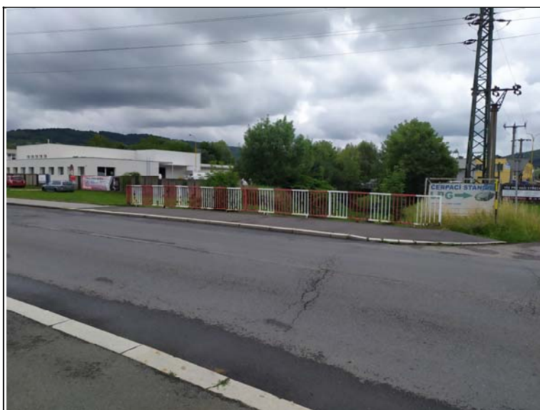
Pravé zábradlí - s pohledem k opěře 2
