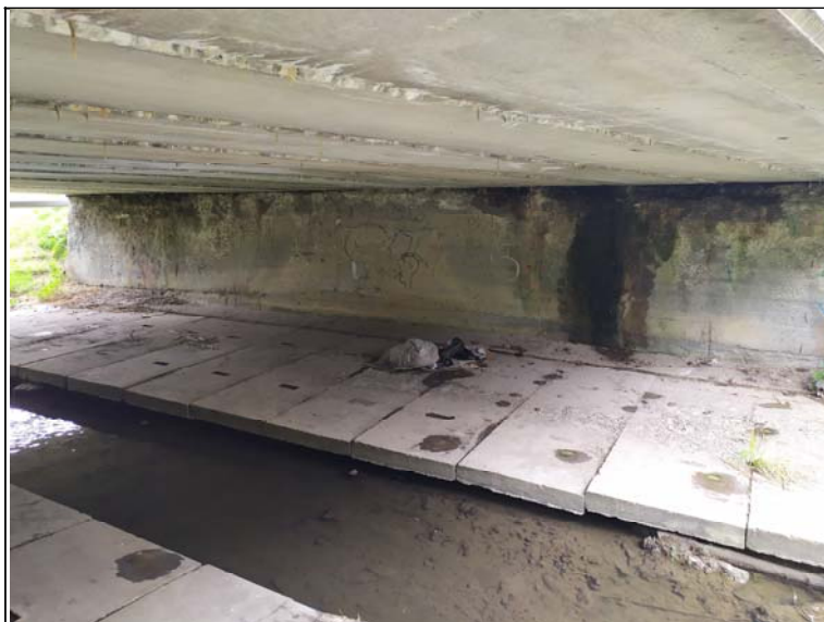
Pohled na opěru 1
