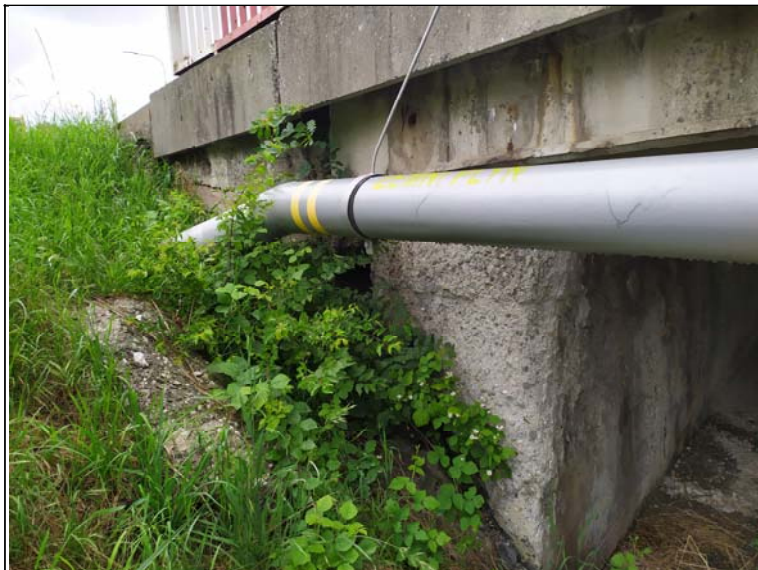
Pohled na pravé křídlo opěry 1
