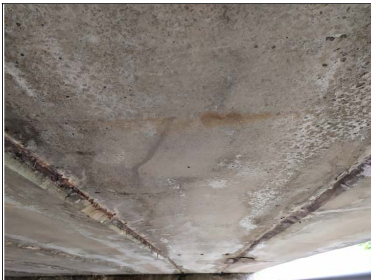
Podhled nosné konstrukce - s pohledem k opěře 2
