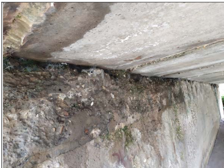
Úložný práh opěry 1
