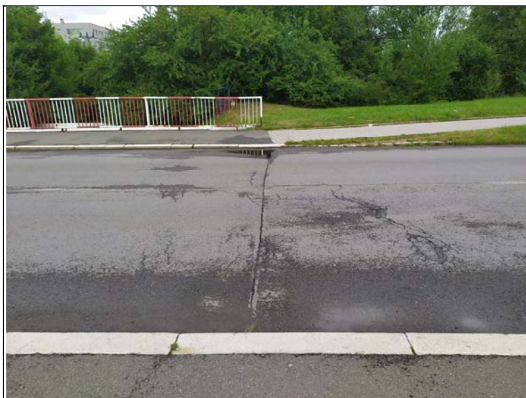
Mostní závěr nad opěrou 2
