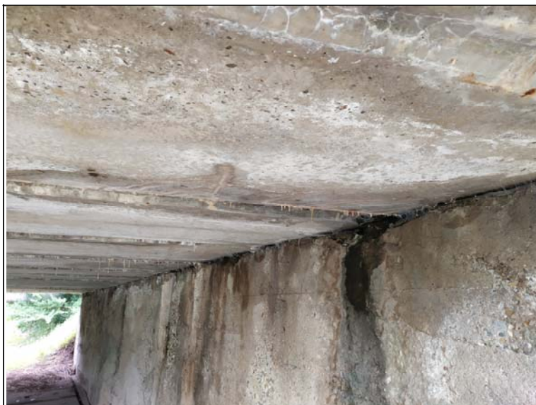
Úložný práh opěry 2
