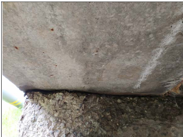
Úložný práh opěry 2
