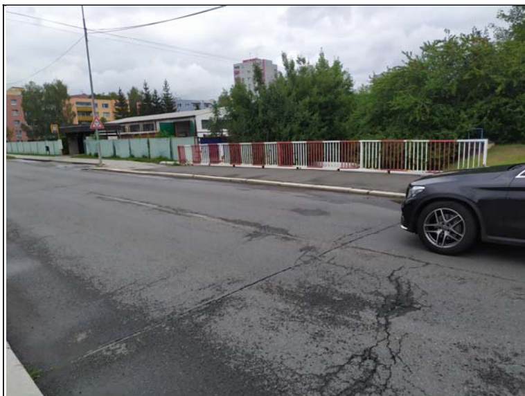
Levé zábradlí - s pohledem k opěře 1
