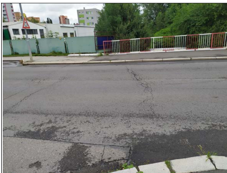
Mostní závěr nad opěrou 1
