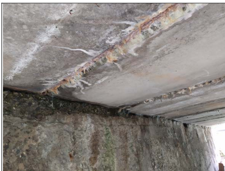
Úložný práh opěry 2
