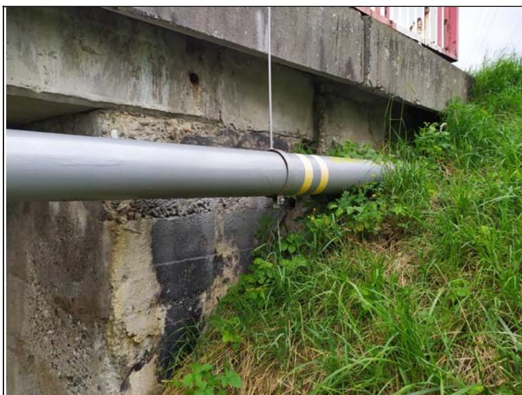
Pohled na pravé křídlo opěry 2
