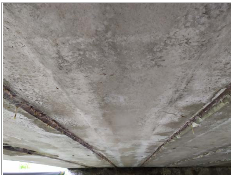
Podhled nosné konstrukce - s pohledem k opěře 1
