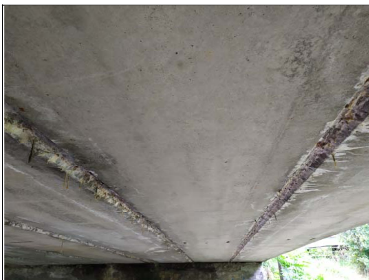
Podhled nosné konstrukce - s pohledem k opěře 1
