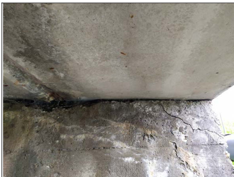
Úložný práh opěry 2
