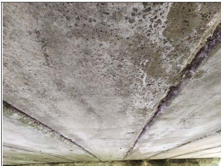
Podhled nosné konstrukce - s pohledem k opěře 1
