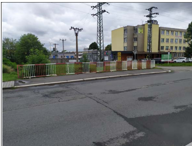
Pravé zábradlí - s pohledem k opěře 1
