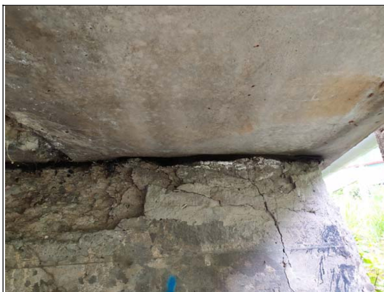
Úložný práh opěry 1
