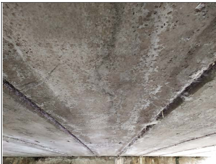
Podhled nosné konstrukce - s pohledem k opěře 2
