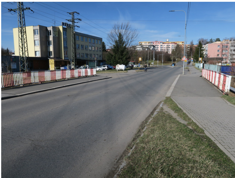
Pohled na most proti směru staničení k ul. Palackého.
