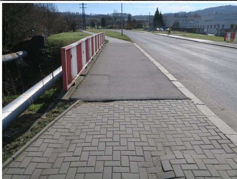
Chodník na mostě vlevo.
