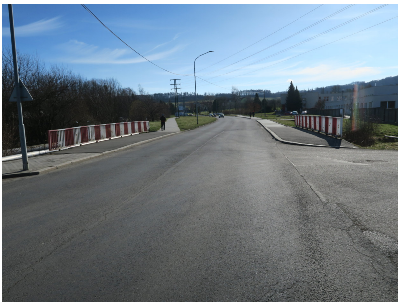
Pohled na most ve směru staničení. Pohled směrem ke Kauflandu.
