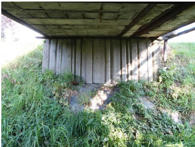
Opěra OP1. Zarostlé, ale funkční opevnění břehu.
