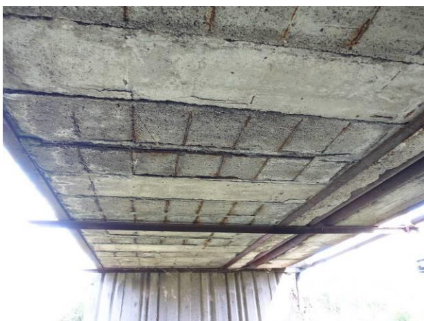
Podhled nosné konstrukce
