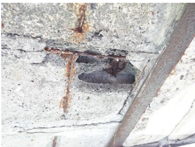
Krátké uložení PZD desek. Rozpad spodního líce desky až do vylehčovacích dutin.
