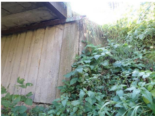
Opěra OP2, pohled zprava
