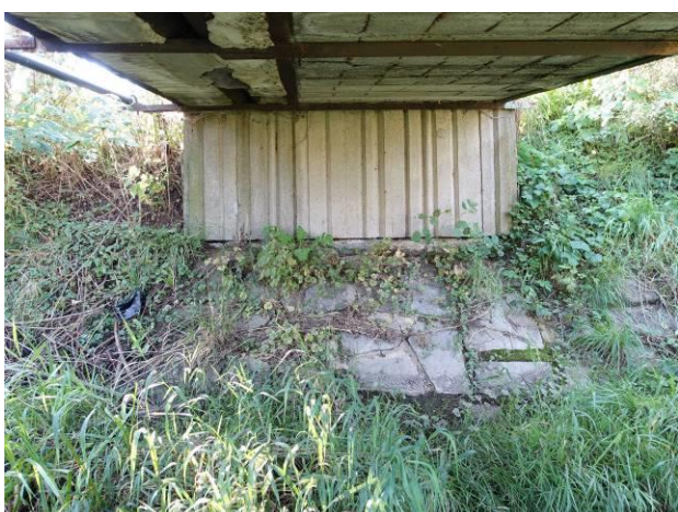
Opěra OP1. Zarostlé, ale funkční opevnění břehu.
