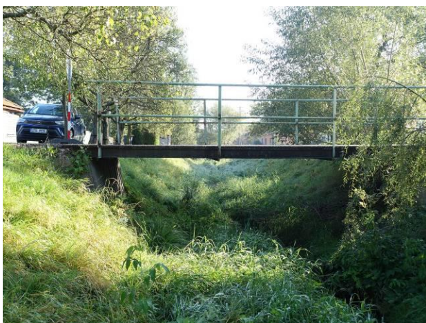
Pohled zprava (vtok)
