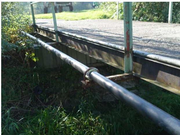
Detail uložení plynovodu
