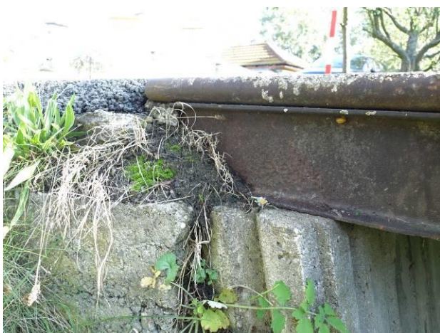
Uložení nosné konstrukce
