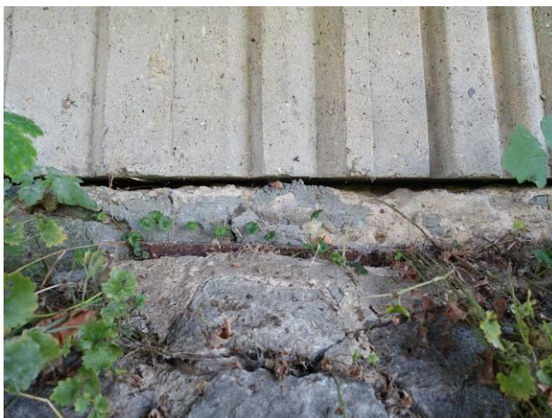
Opěra OP2. Odhalená malá horní část základu. Mezi základem a lícním prefabrikátem je spára.
