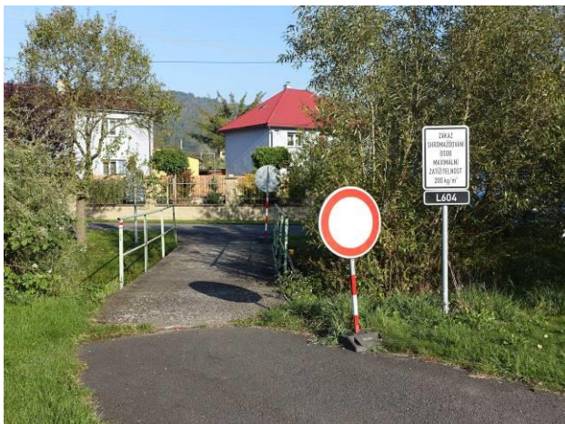
Pohled na lávku proti směru orientace záznamu
