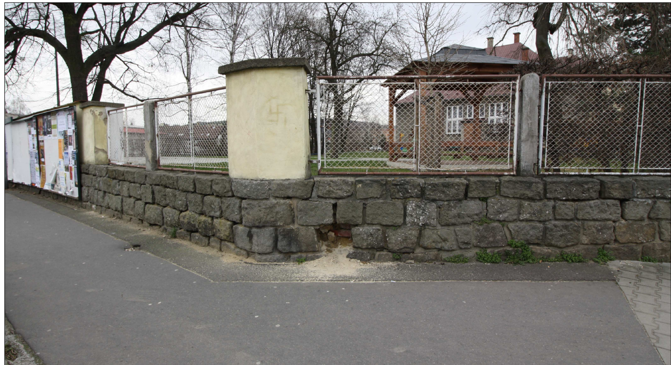
FOTO Č.17: ČÁST C2– VYPADÁVAJÍCÍ PODEZDÍVKA
