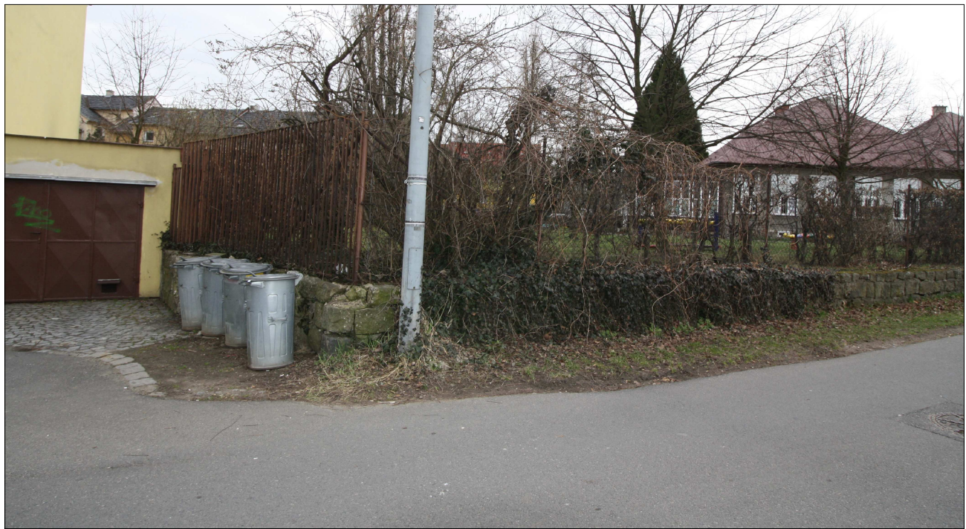
FOTO Č.18: ČÁST C2, C3– ZAROSTLÁ, VYPADÁVAJÍCÍ PODEZDÍVKA
