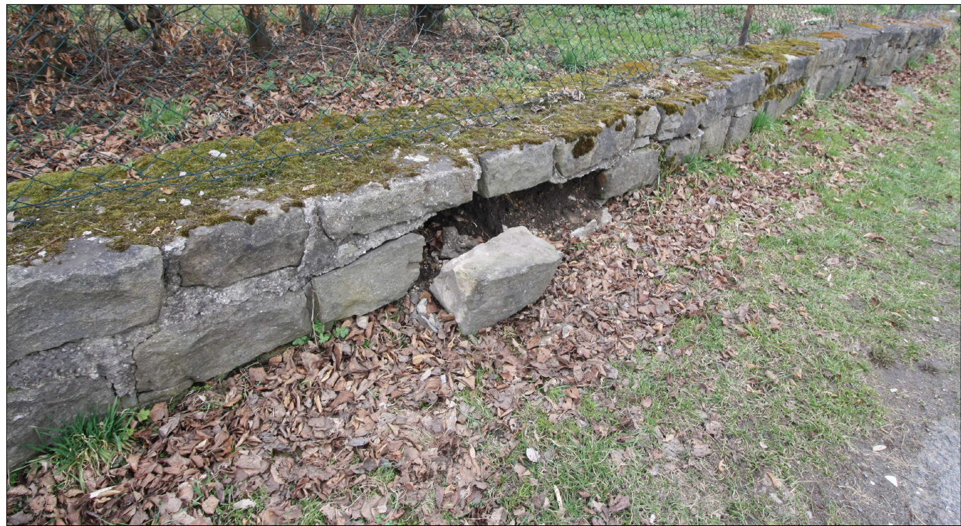
FOTO Č.17: ČÁST C2– VYPADÁVAJÍCÍ PODEZDÍVKA
