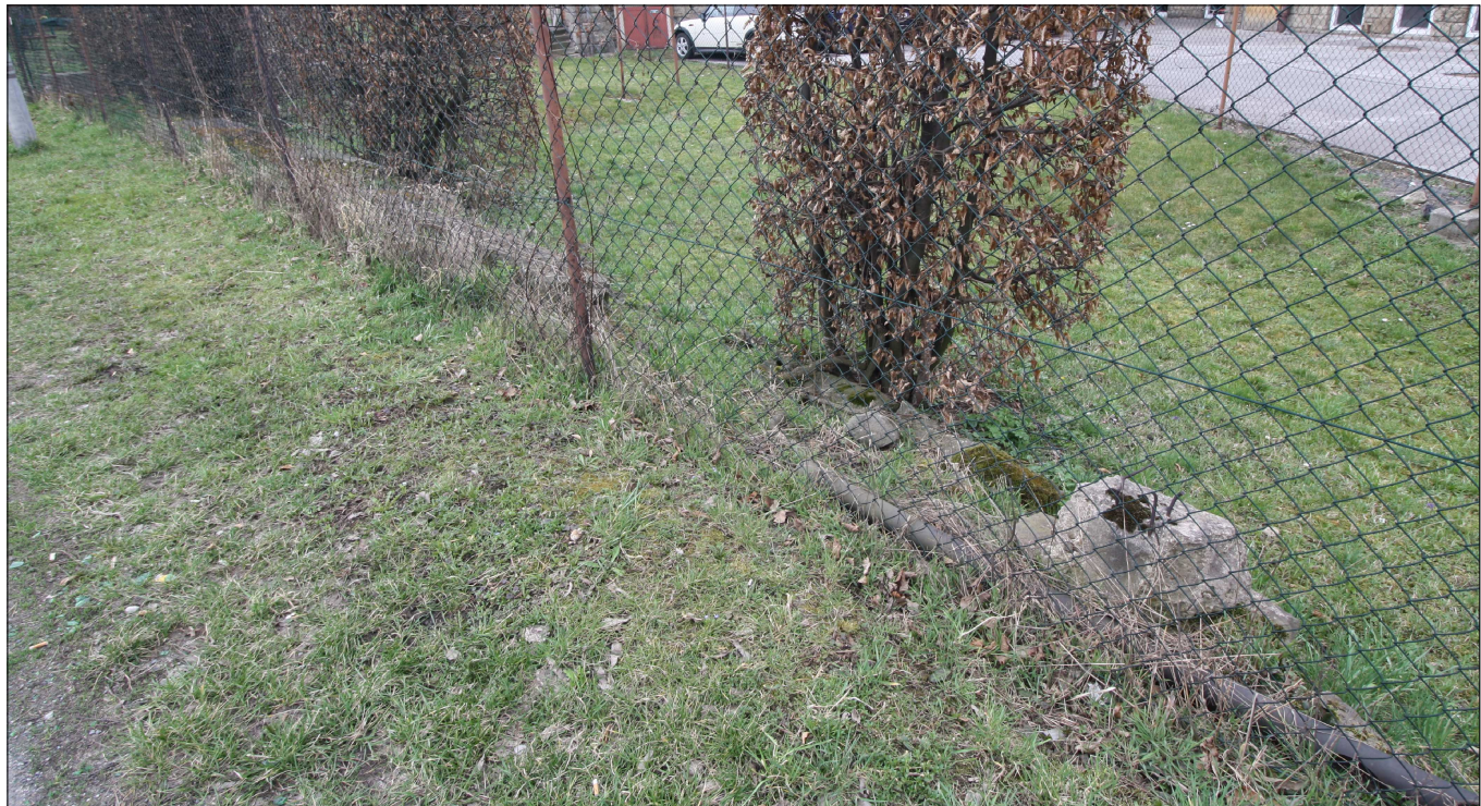
FOTO Č.18: ČÁST C2, C3– ZAROSTLÁ, VYPADÁVAJÍCÍ PODEZDÍVKA
