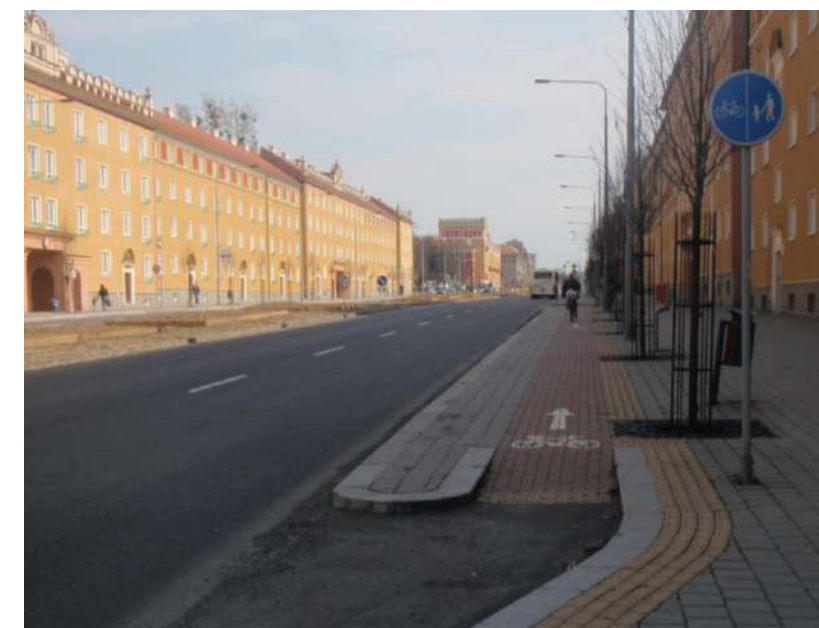
Ukázka návaznosti cyklostezky v přidruženém prostoru na komunikaci s velkou intenzitou cyklistů, kde je oddělení od chodců prostřednictvím vysázených stromů.
