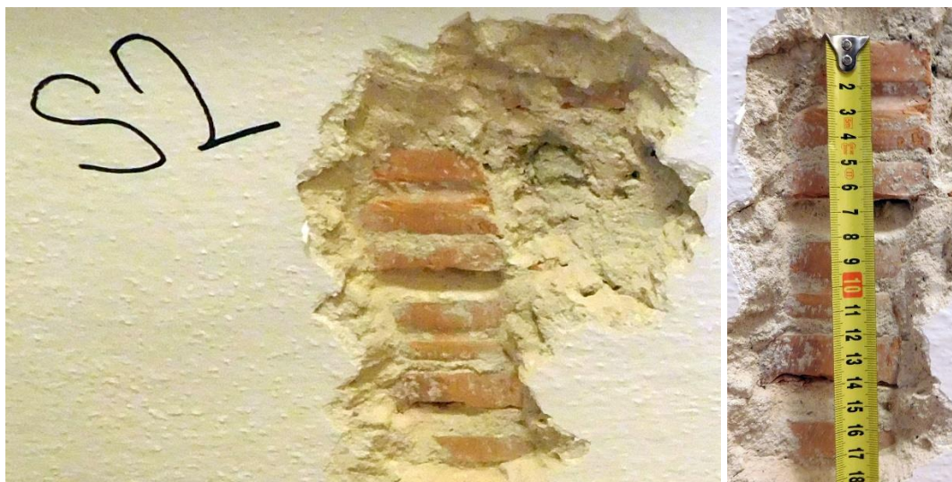
Obrázek 79: Sonda S2, 3.NP, vnitřní příčka, duté pálené cihly.
