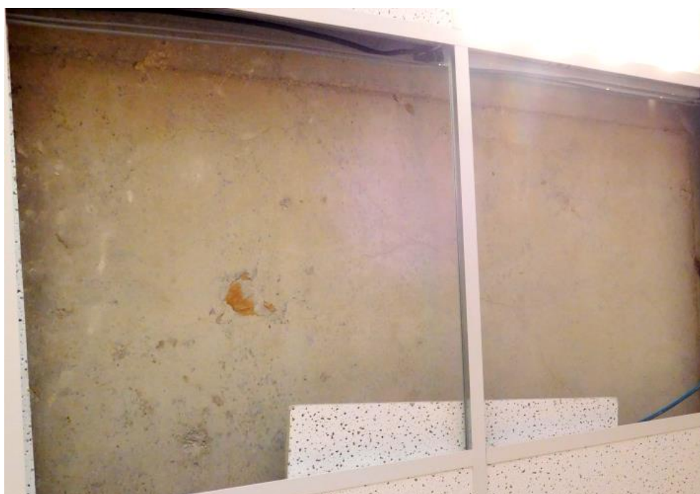
Obrázek 33: Odkrytá část stropu (kancelář správce, 3.NP).
