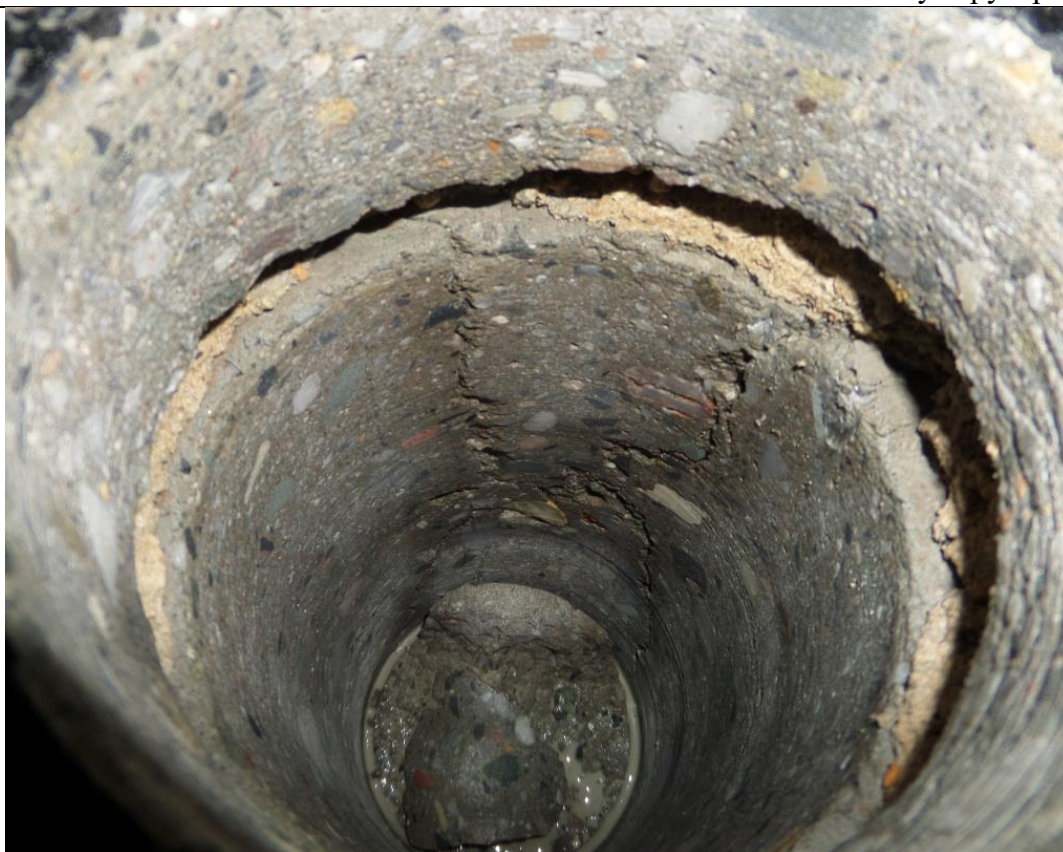
Obrázek 73: Vývrt V6 (strop nad 3.NP, pokoj).
