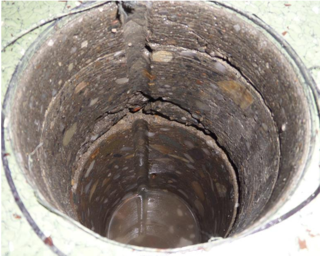
Obrázek 57: Vývrt V1 (strop nad 2.NP, chodba).
