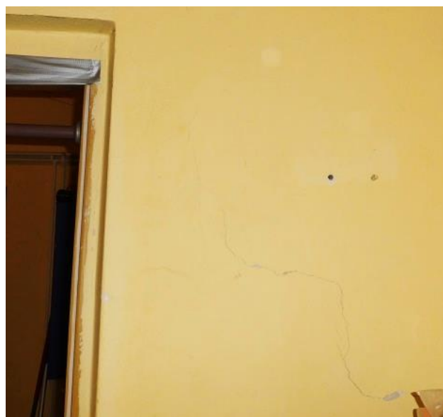
Obrázek 48: Trhliny příčkami, 4.NP.
