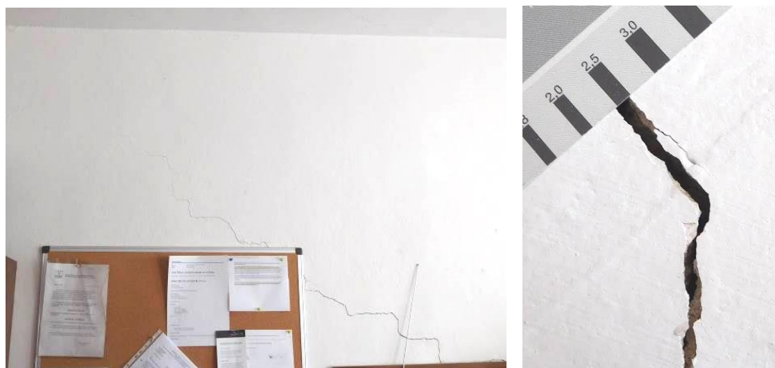
Obr. 9 – Šikmá trhlina příčkou.
