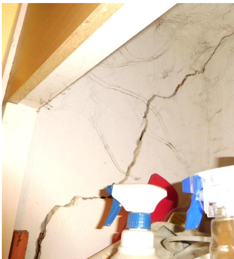
Obrázek 46: Trhliny příčkovou nikou pro vestavěné skříň, větší než 5 mm, 4.NP.
