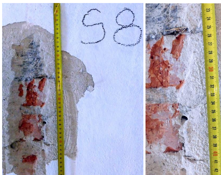
Obrázek 85: Sonda S8, 2.NP, obvodová nosná stěna, cihly plné.
