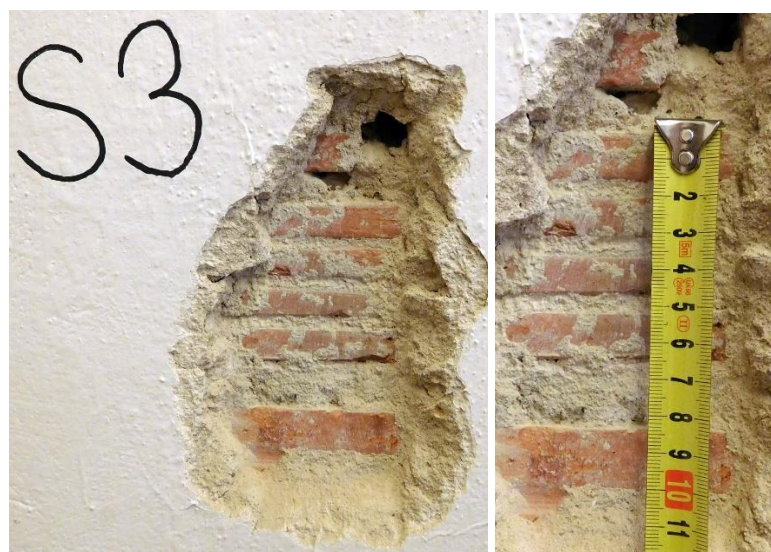
Obrázek 80: Sonda S3, 3.NP, vnitřní příčka, duté pálené cihly.
