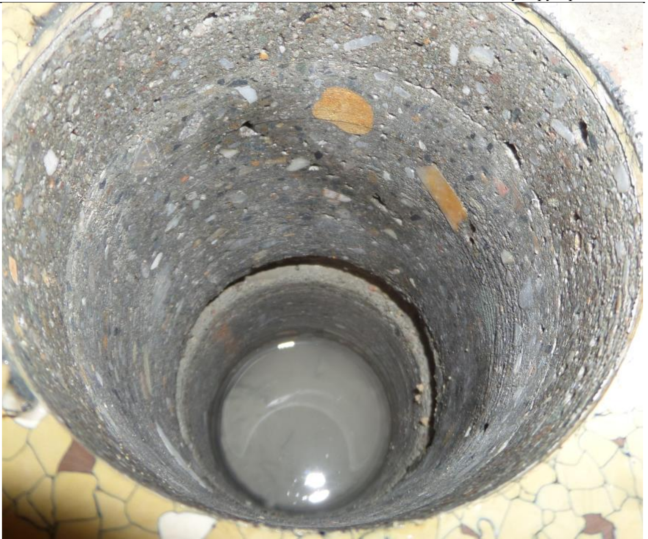
Obrázek 71: Vývrt V5 (strop nad 3.NP, chodba).
