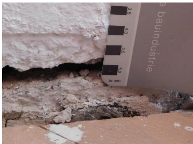
Obrázek 16: Šířka trhliny.
