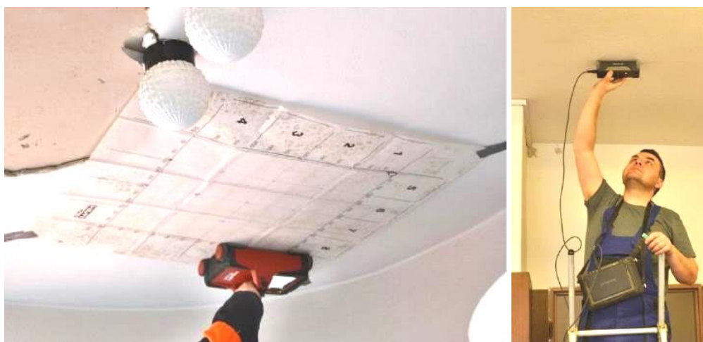
Obr. 30 – Ukázka z realizace skenů výztuže.
