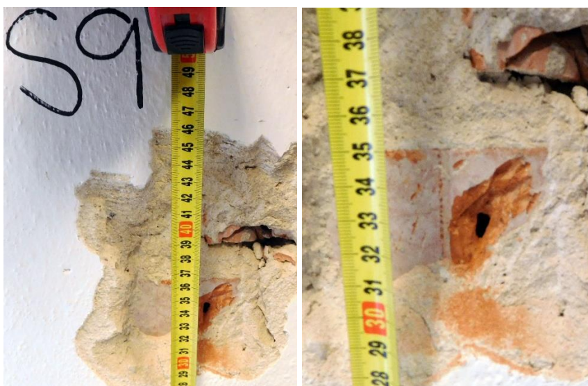
Obrázek 86: Sonda S9, 3.NP, obvodová nosná stěna, děrované pálené cihly.
