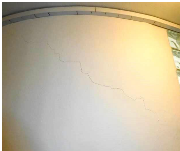
Obr. 12 – Další trhliny příčkami.
