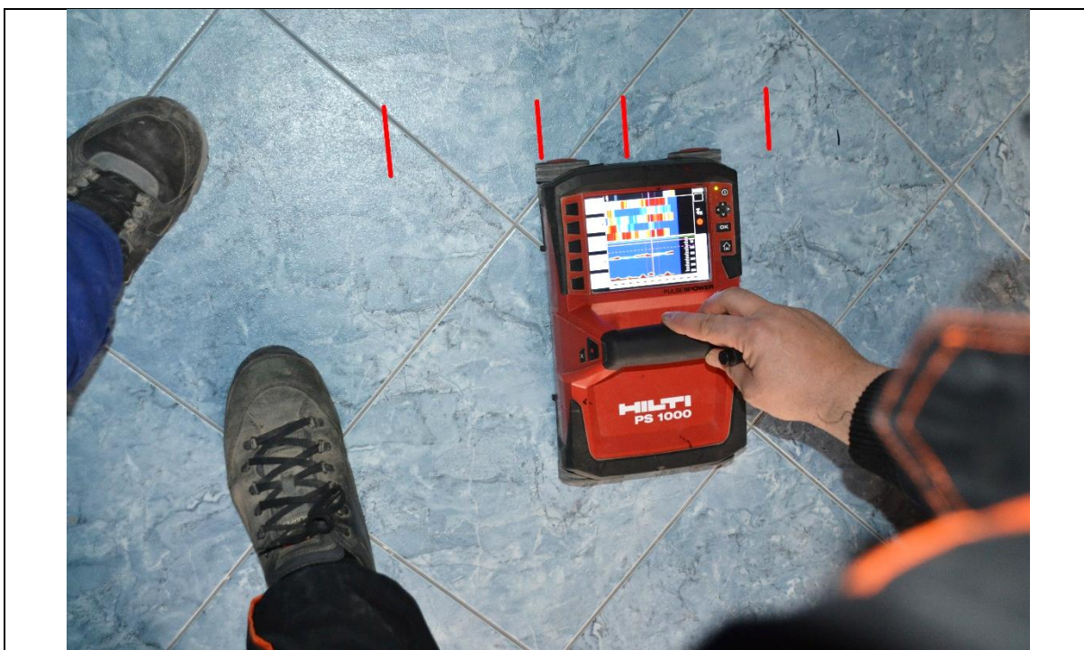
Obr. 3.4: Liniový radarový sken v místě jádrového vývrtu pro vytyčení oblastí, kde lze bezpečně vrtat.
