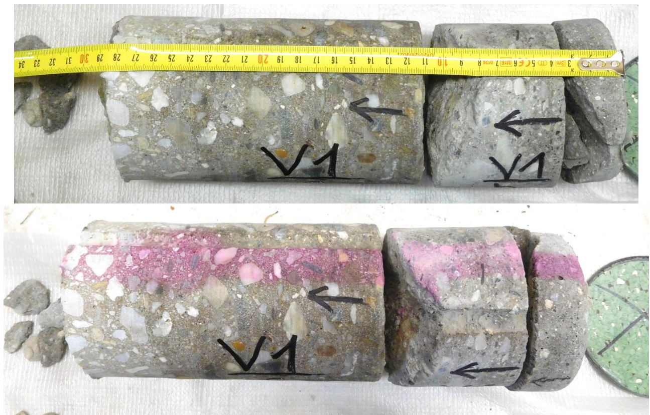
Obrázek 58: Vývrt V1 (strop nad 2.NP, chodba).
