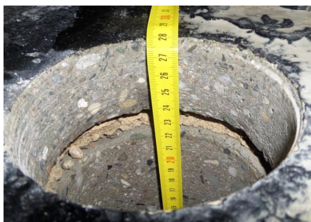
Obrázek 74: Vývrt V6 (strop nad 3.NP, pokoj).
