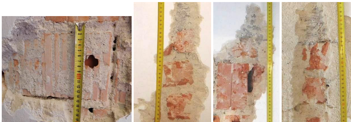
Obr. 34 – Sekané sondy do zdiva (zleva S5, S6, S7, S8).
