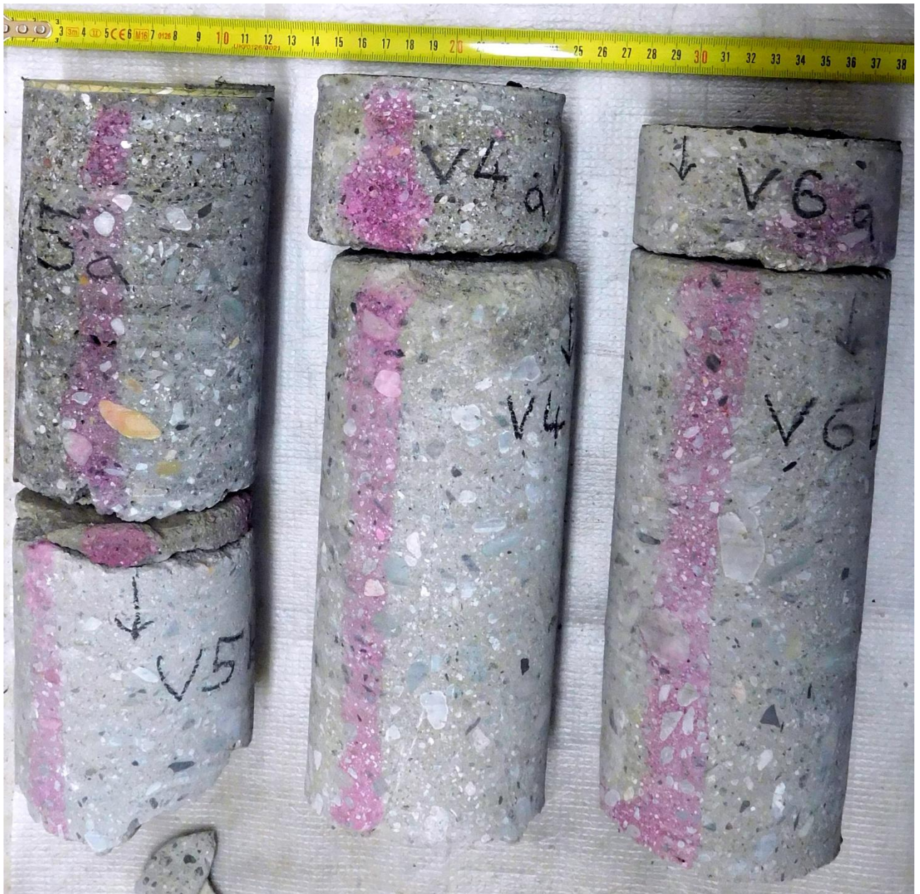
Obrázek 76: Vývrtý ze stropní desky nad 3.NP.
