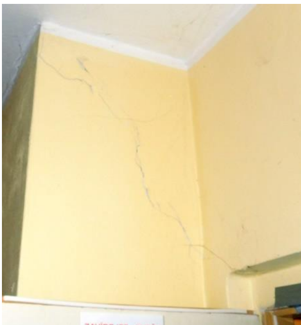
Obrázek 48: Trhliny příčkami, 4.NP.
