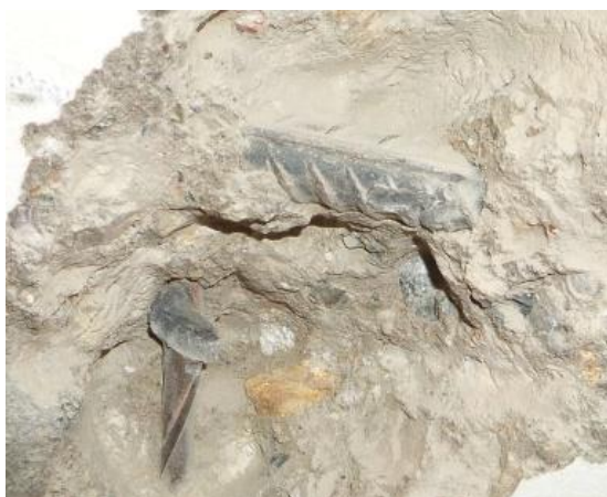
Obrázek 49: Výztuž v sondě D2-1, \phi V14 + \phi T6 (spodní povrch stropu nad 2.NP).
