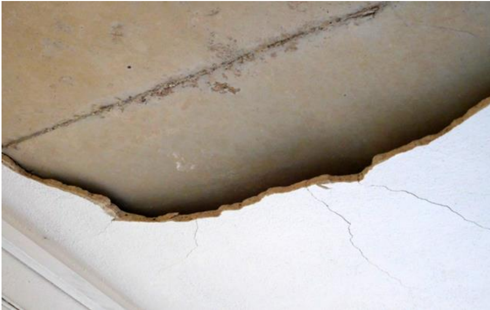
Obrázek 14: Uvolňování nesoudržných omítek (koupelna ve 3.NP).
