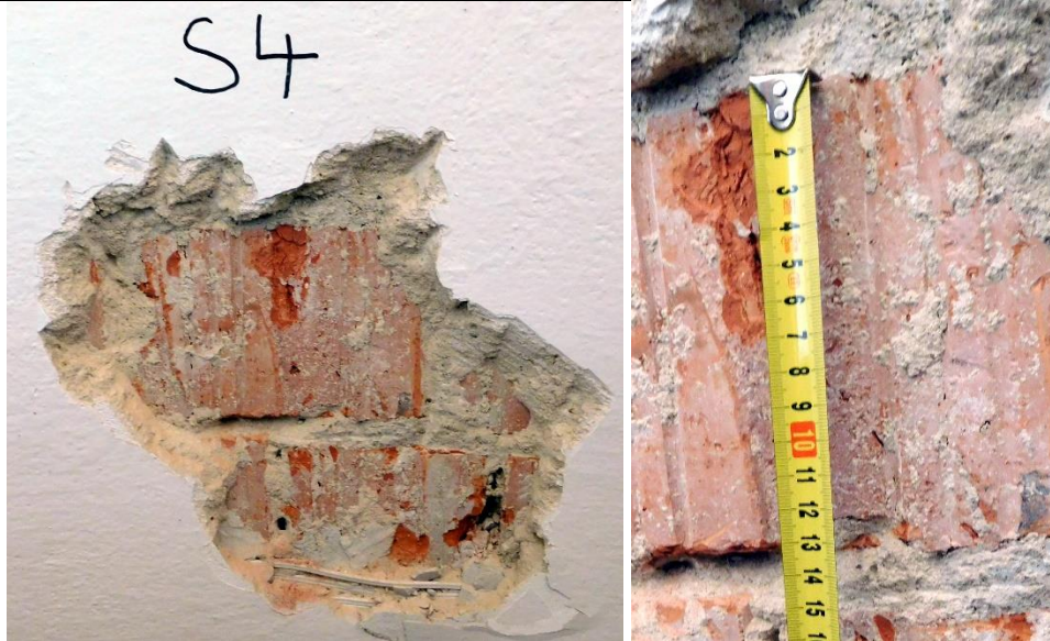
Obrázek 81: Sonda S4, 3.NP, obvodová nosná stěna, děrované pálené cihly.
