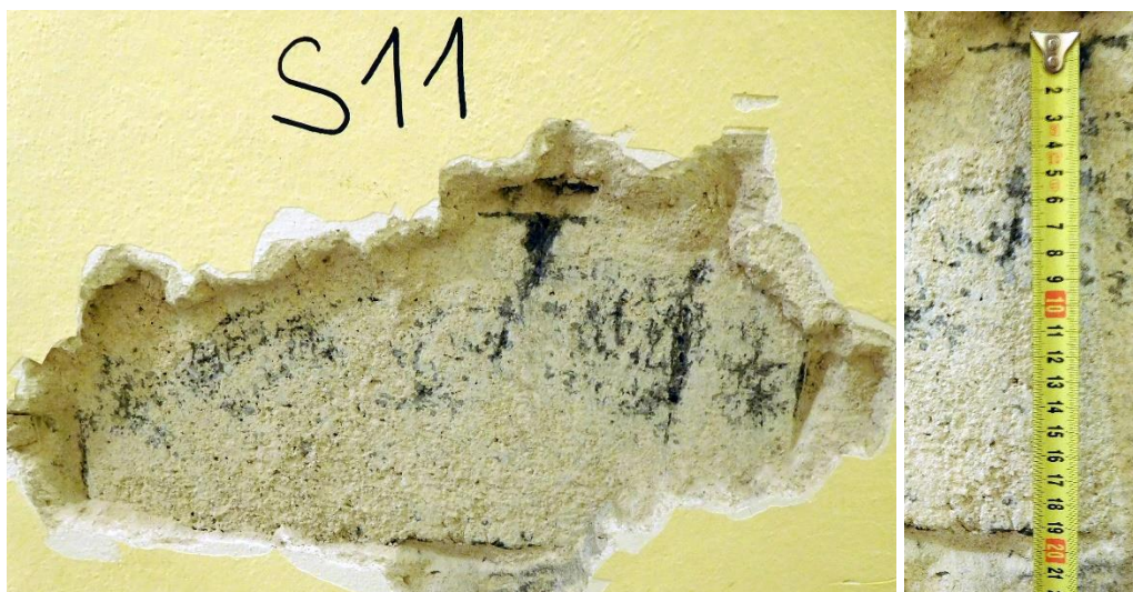
Obrázek 88: Sonda S11, 4.NP, vnitřní příčka, tmavá (silikátová/škvárová) tvarovka, nejedná se o pálenou cihlu.
