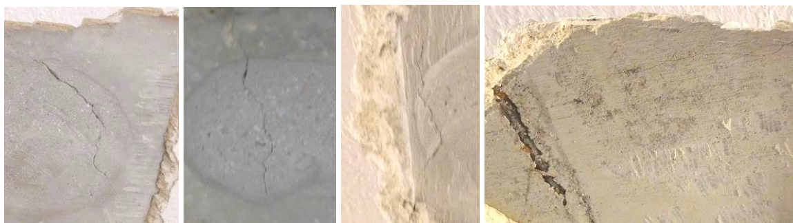
Obr. 22 – Trhlinky odkryté pod omítkou při přípravě zkušebních míst pro Schmidtův tvrdoměr. Šířka trhlin nepřesahuje 0,5 mm, na obrázku vpravo je patrná výztuž s nulovým krytím.
