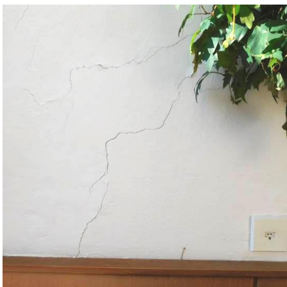
Obr. 12 – Další trhliny příčkami.
