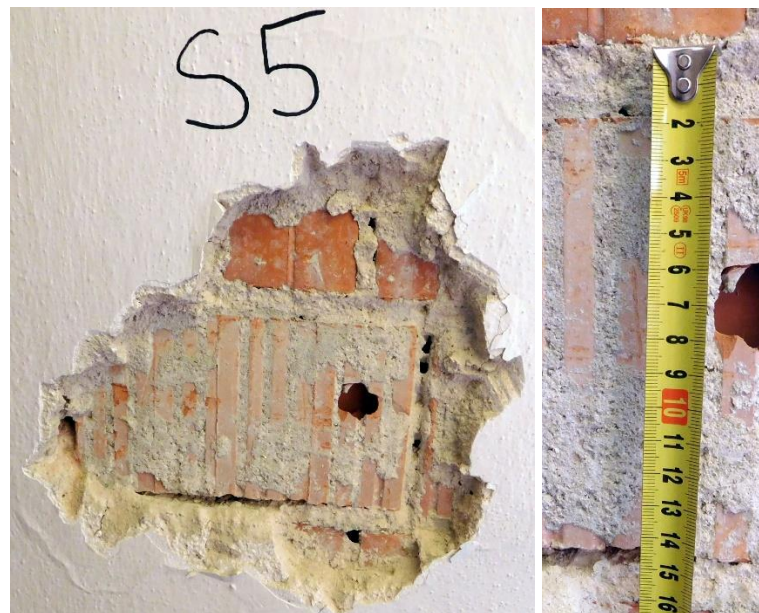
Obrázek 82: Sonda S5, 3.NP, obvodová nosná stěna, děrované pálené cihly.
