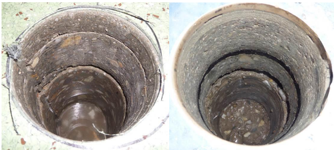
Obr. 27 – Vývrty po odběru vzorku V1 (vlevo) a V2 (vpravo).
