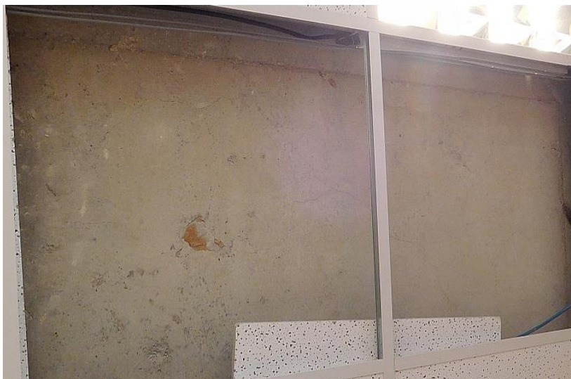
Obr. 19 – Zpřístupněná část spodního líce stropu (kancelář správce, 3.NP).
