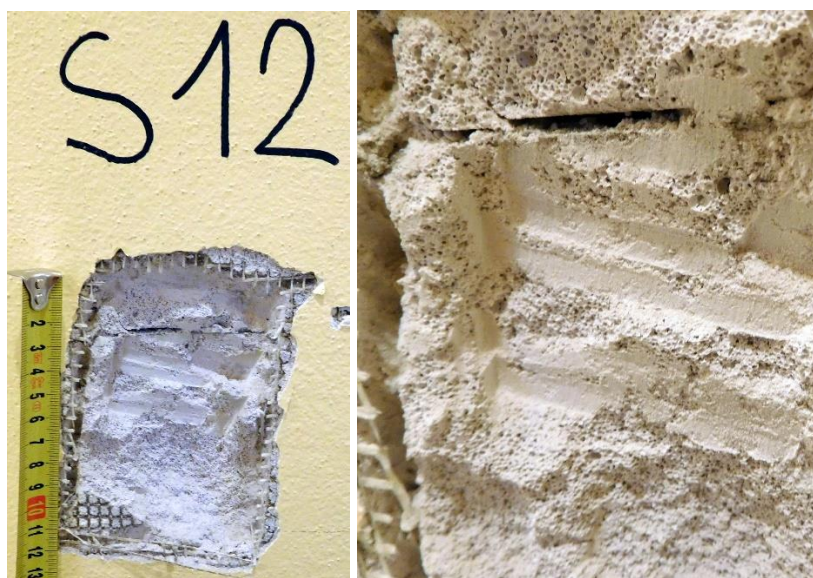
Obrázek 89: Sonda S12, 4.NP, vnitřní příčka, světlá tvarovka (silikátová, obdoba Ytongu).
