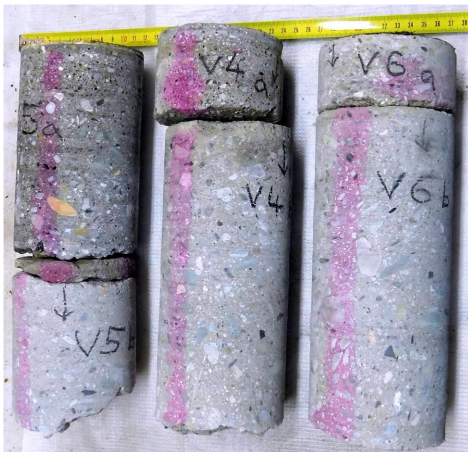
Obr. 26 – Jádrové vývrty ze stropní desky nad 3.NP.
