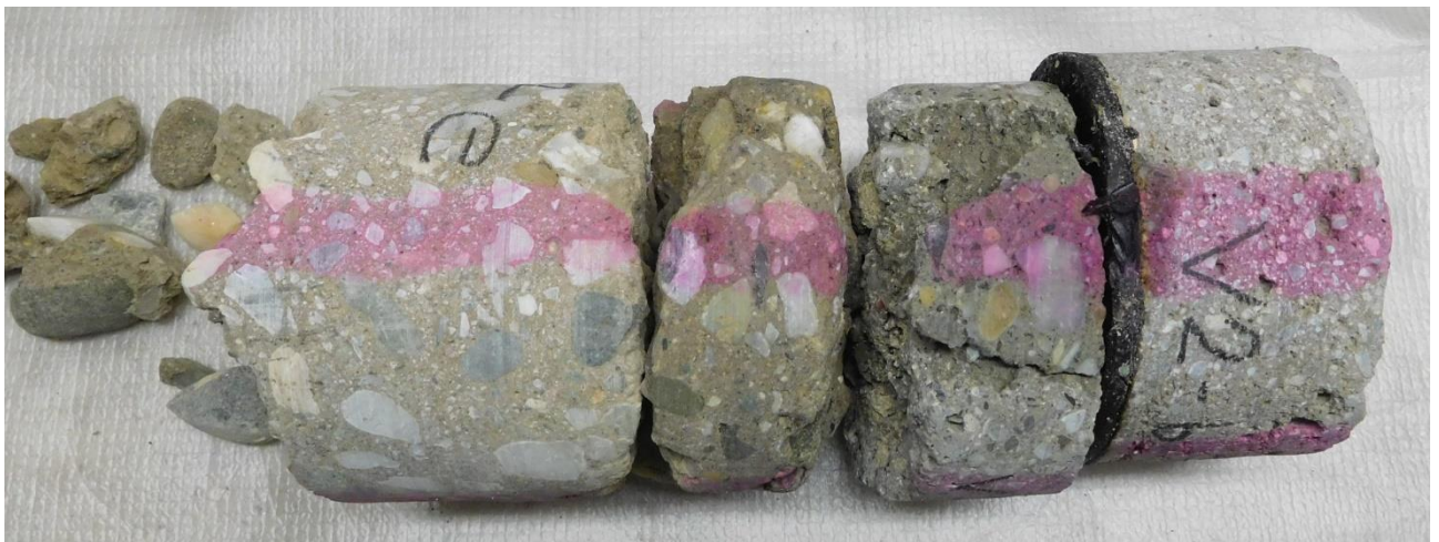
Obrázek 63: Výtvt V2 (strop nad 2.NP, koupelna).
