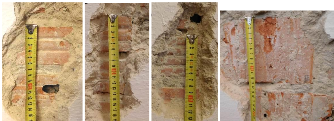
Obr. 33 – Sekané sondy do zdiva (zleva S1, S2, S3, S4).
