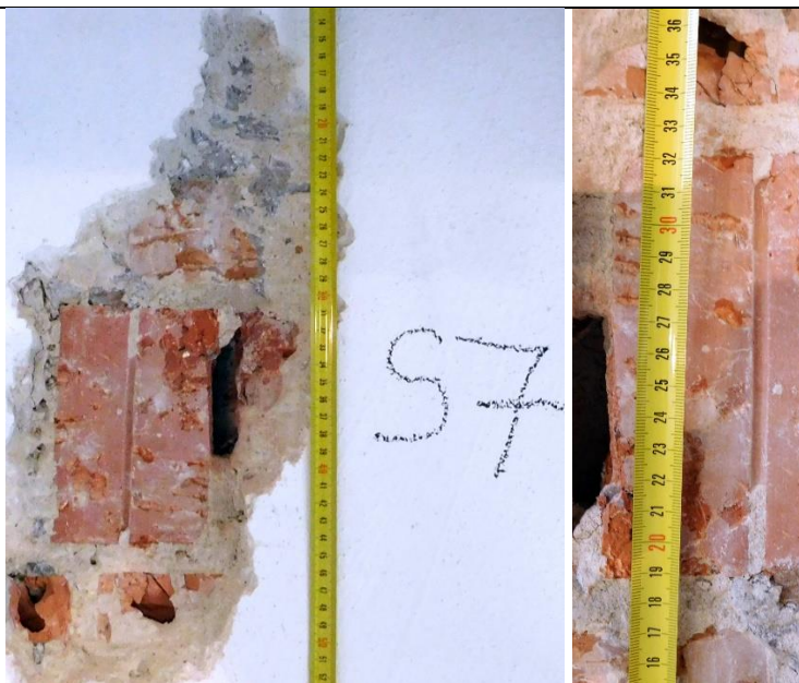
Obrázek 84: Sonda S7, 2.NP, vnitřní nosná stěna, betonový věnec, zdivo – cihly děrované.
