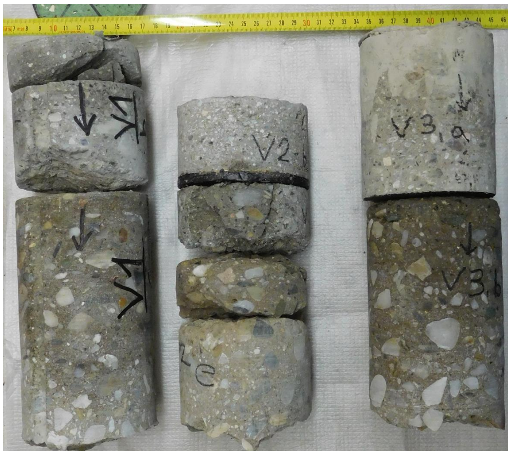
Obrázek 67: Vývrty ze stropní desky nad 2.NP.
