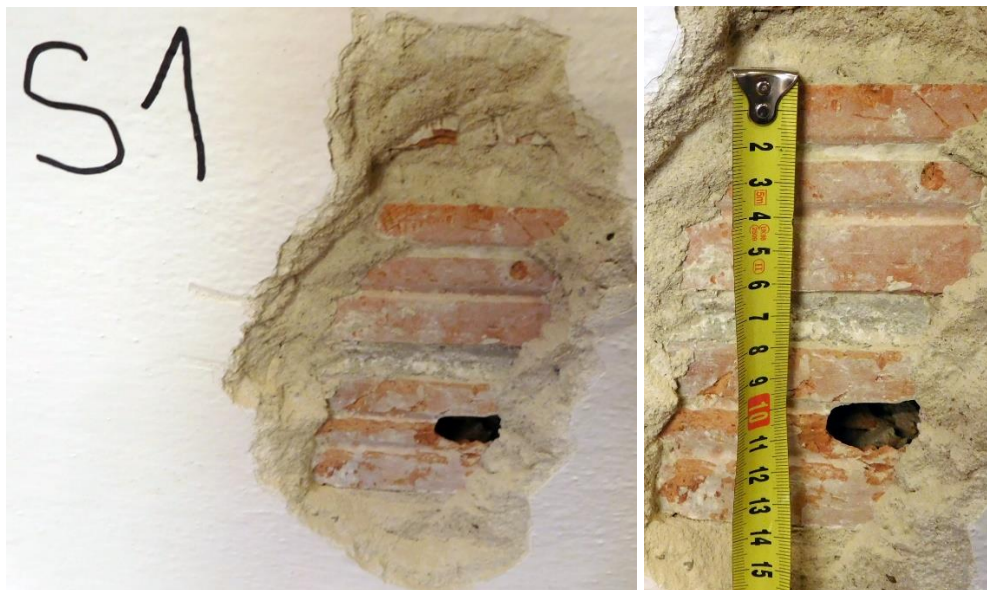
Obrázek 78: Sonda S1, 3.NP, vnitřní příčka, duté pálené cihly.
