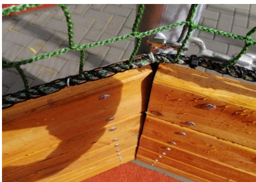
Chybně provedené napojení mantinelu v šikmém rohu
