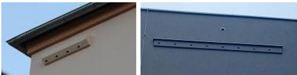
Obr. hnízdní budky pro rorýse čtyřkomorová, umístěná na fasádu, dvě čtyřkomorové umístěné ve fasádě.
