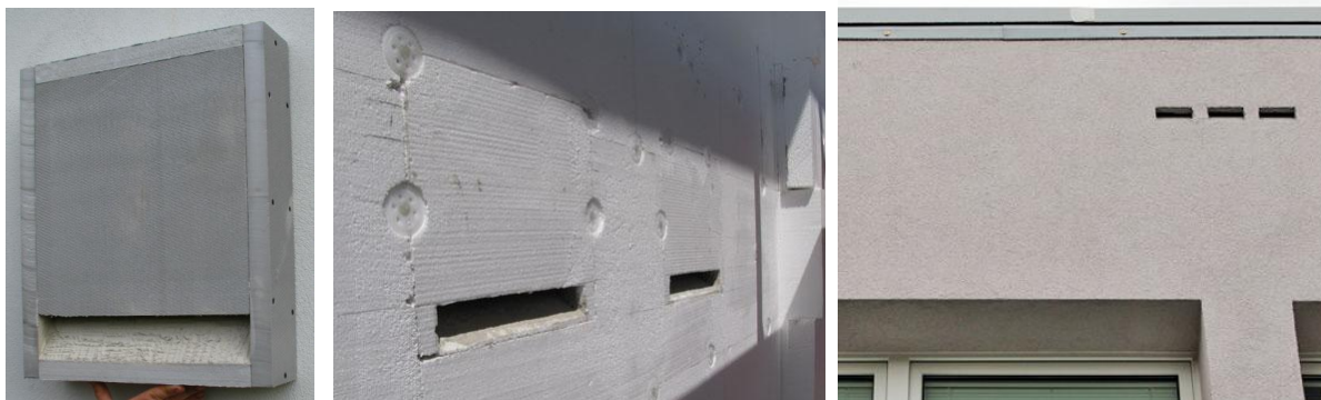
Obr. budka pro netopýry do izolačního materiálu, ukázka instalace, ukázka hotové fasády se zabudovanou budkou
