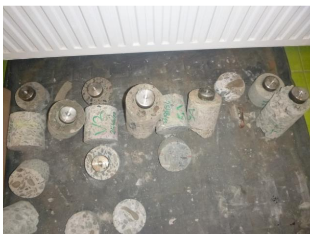
Celkový pohled na nalepené terče na povrchu betonu a v různých hloubkách.
