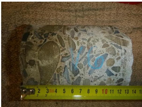
Pohled na vývrt V6 do ÚP OP1.
