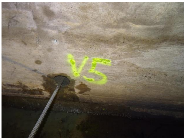
Pohled na vrtání tl. průměru 20 mm.
