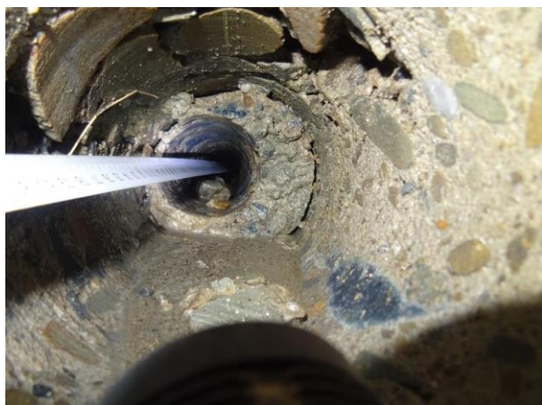
Pohled do vývrtnu.
