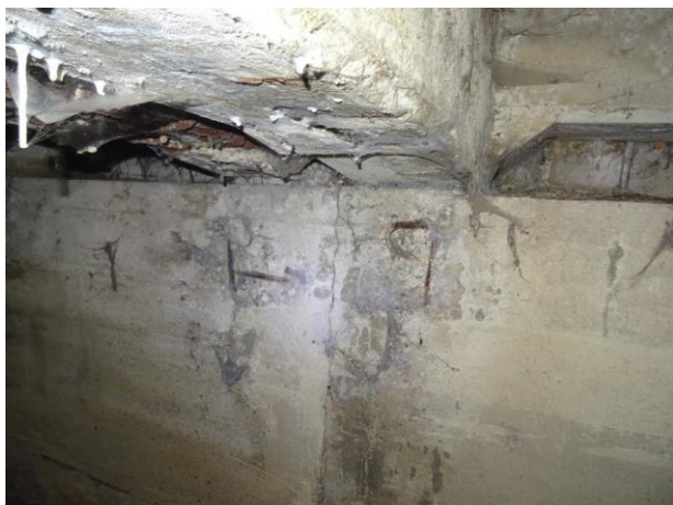
Viditelná dilatační spára, viditelná měkká výztuž ÚP výšky 35 cm.
