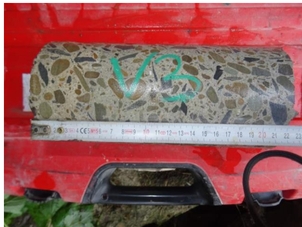
Pohled na vývrt V3 do ÚP OP1.
