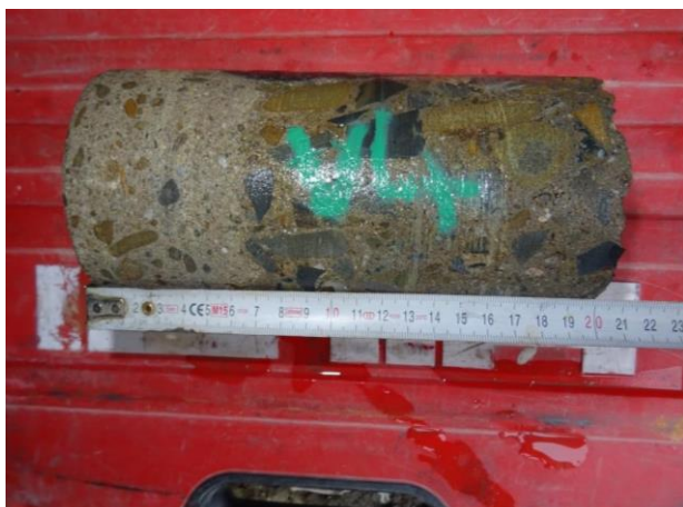
Pohled na vývrt V4 do dřívku OP1.
