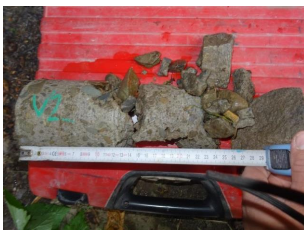
Vývrt V2 do dříku OP2. Viditelná přibetonávka. Velká heterogenita betonu. Rozpad cementového tmele.
