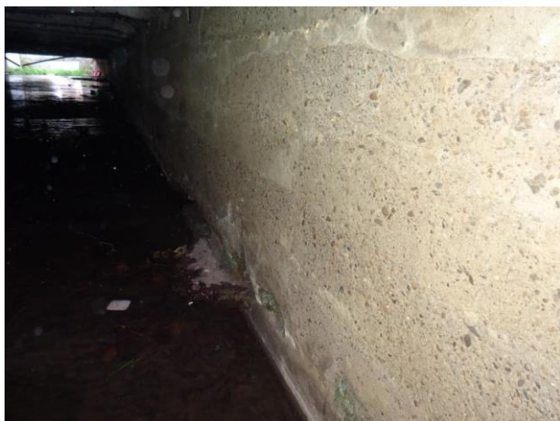
Viditelné kaverny v úrovni hladiny, viditelné podélné pracovní spáry.
