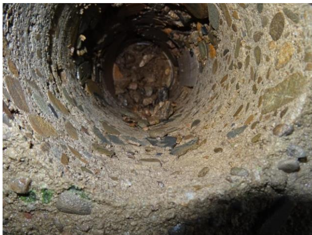
Pohled do vývrtu V2. Viditelně silně pórovitý beton. Nehomogenní struktura s netříděným říčním kamenivem.
