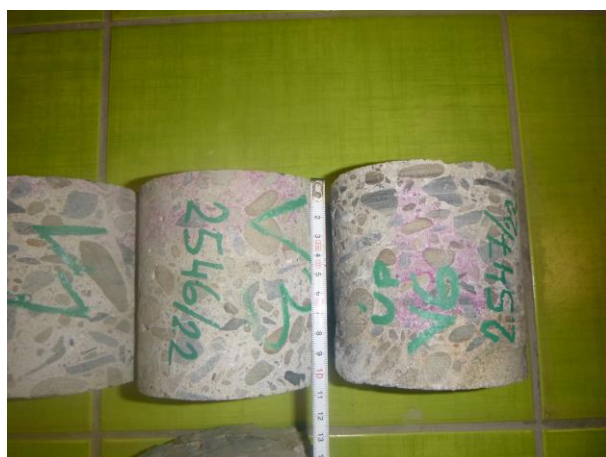
Pohled na upravené vývrty ÚP spodní stavby.
