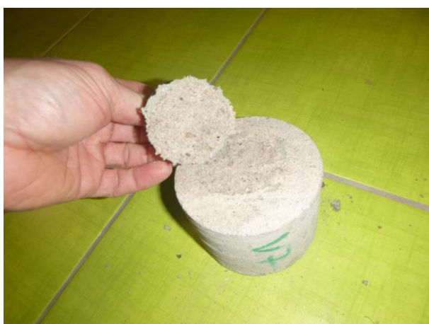
Pohled na kohezní poruchu na vývrty V7 při hodnotě 1,08 MPa.
