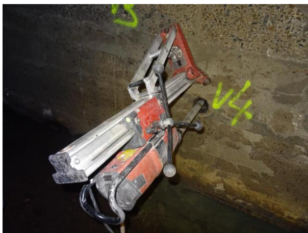
Pohled na vývrt V4 do dříku přes celou tloušťku.
