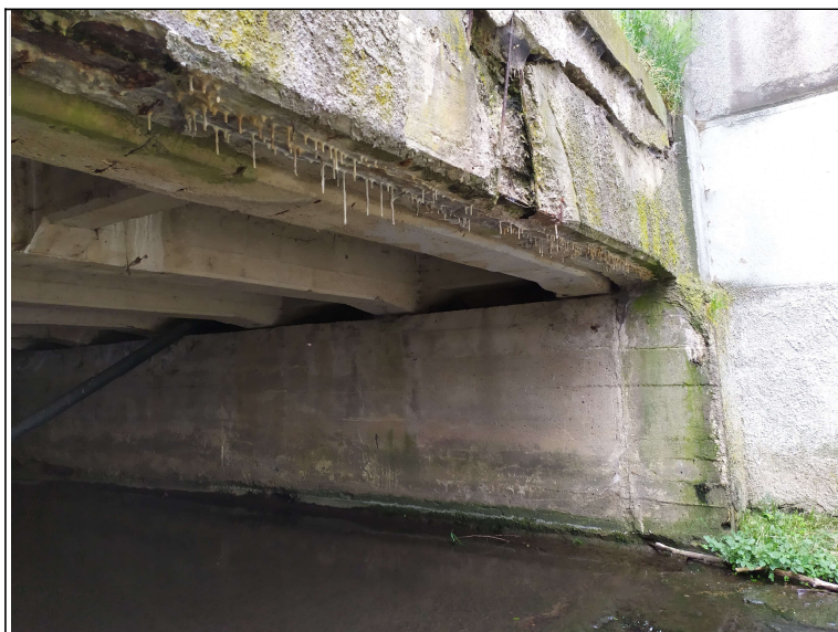
Pohled na opěru 2
