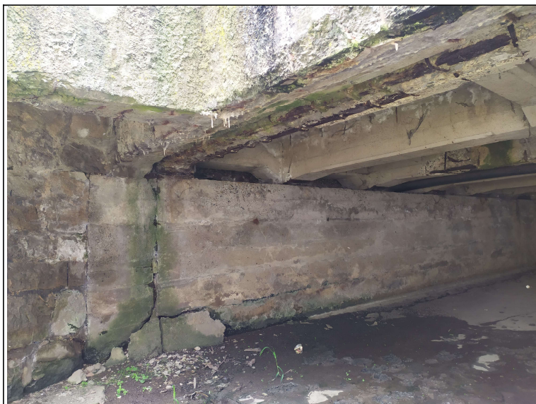
Pohled na opěru 1
