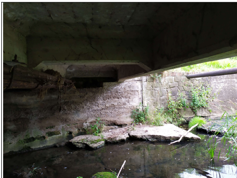
Pohled na opěru 1
