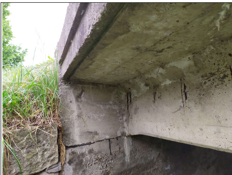
Podhled nosné konstrukce - s pohledem k opěře 2
