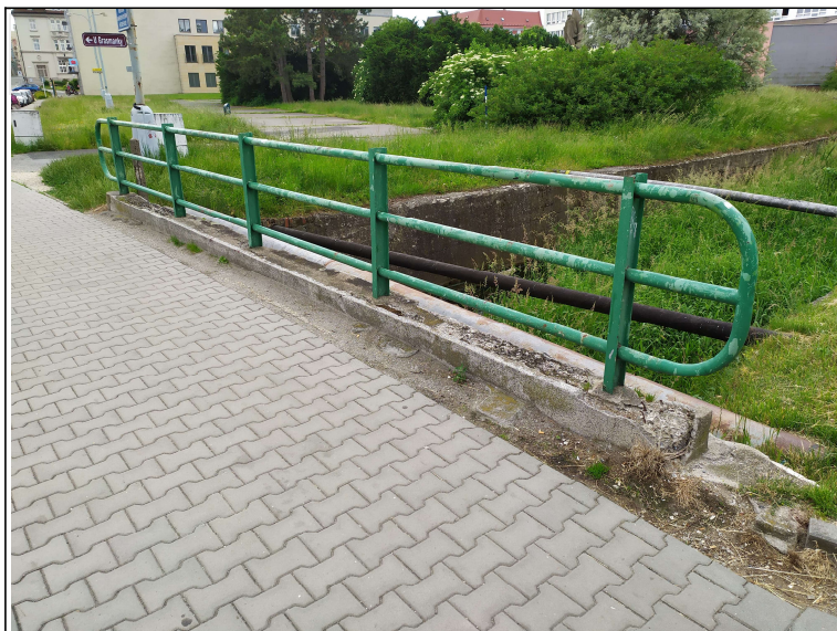
Levé zábradlí - s pohledem k opěře 1
