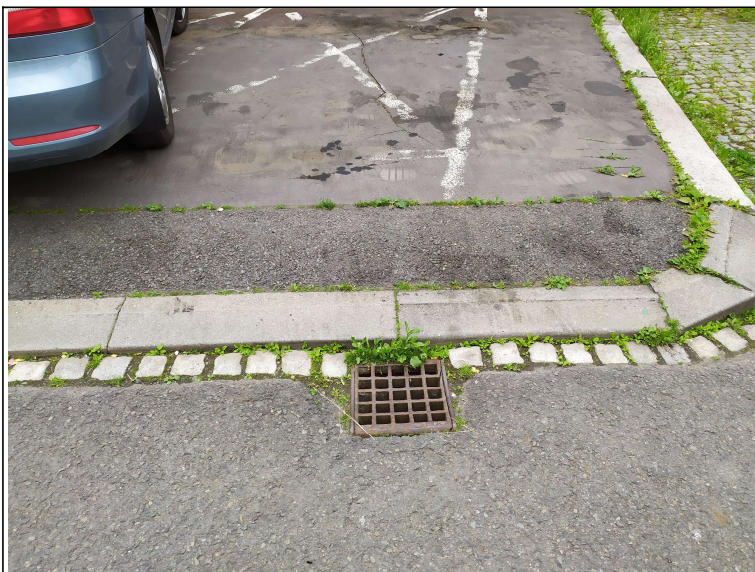
Mostní odvodňovač - shora
