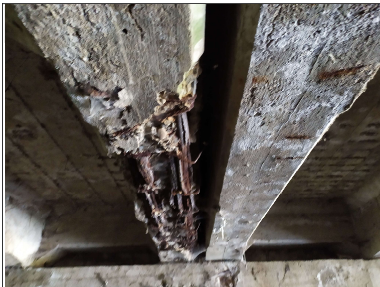
Podhled nosné konstrukce - s pohledem na úložný práh
