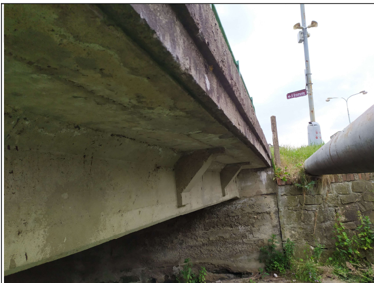
Podhled nosné konstrukce - s pohledem k opěře 1
