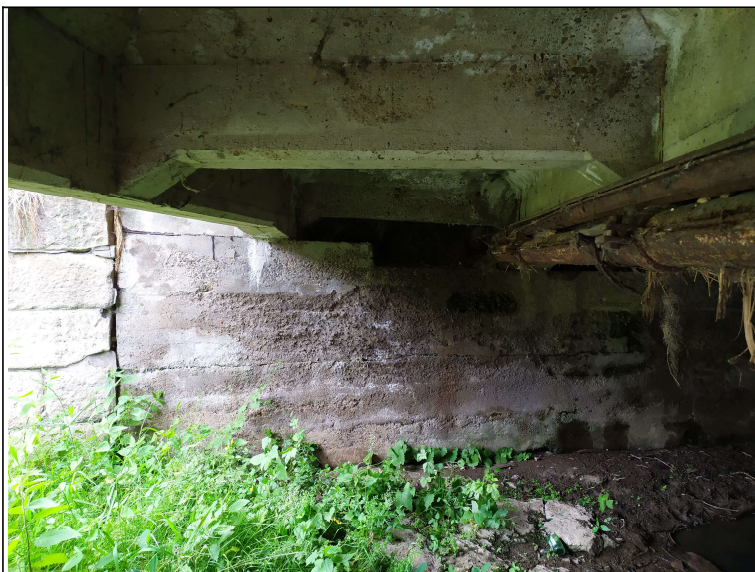
Pohled na opěru 2
