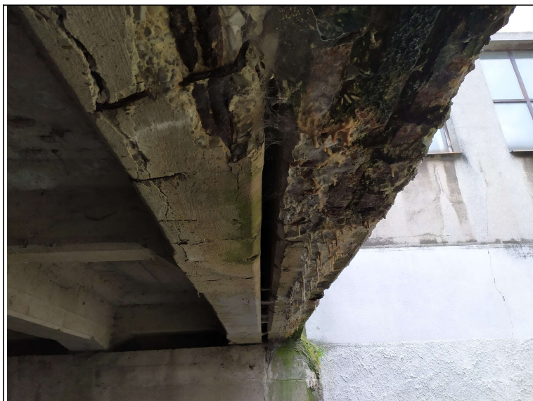
Podhled nosné konstrukce - s pohledem k opěře 2
