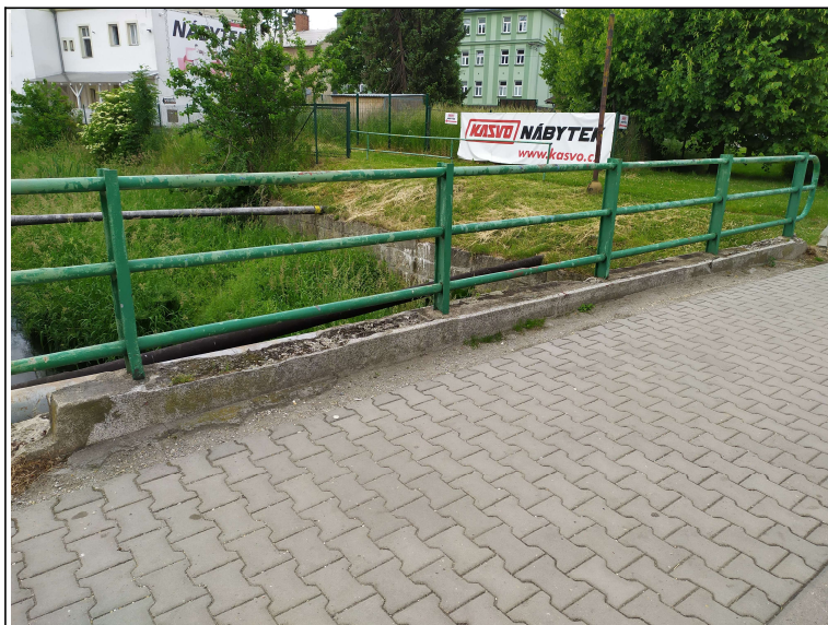
Levé zábradlí - s pohledem k opěře 2
