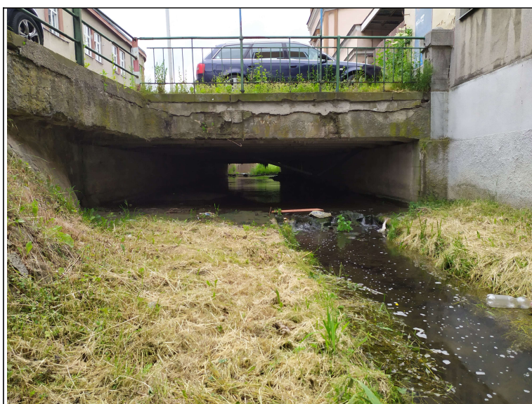
Prostorové uspořádání pod mostem (povodní)
