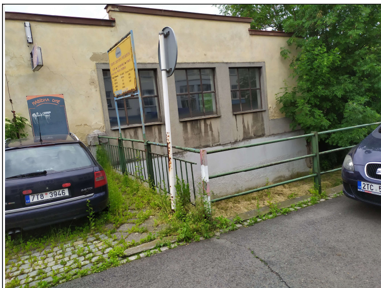
Pravé zábradlí - s pohledem k opěře 2
