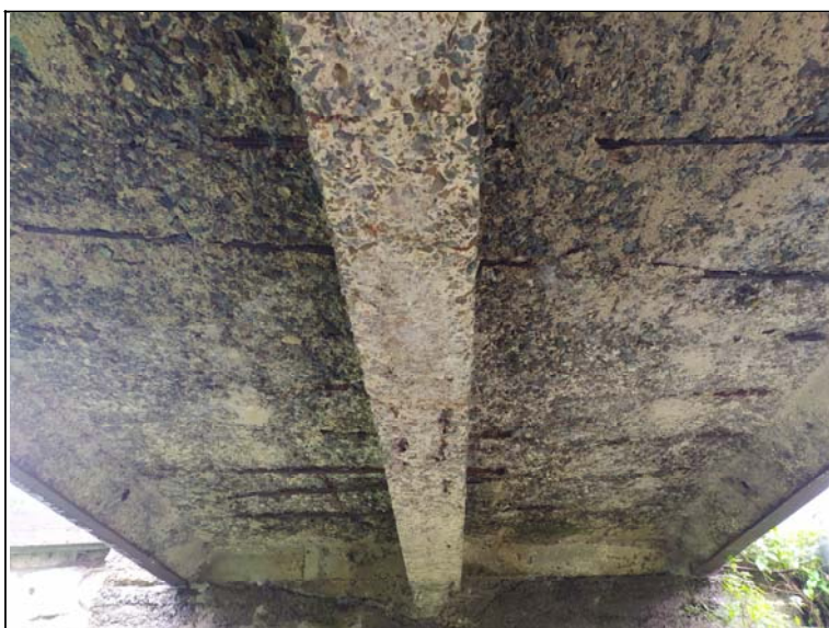
Podhled nosné konstrukce - s pohledem k opěře 1
