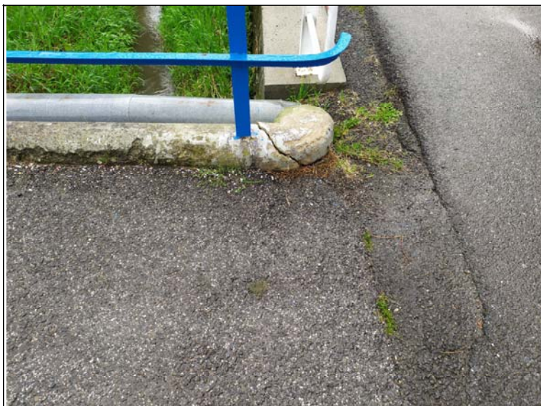
Pohled na dilataci opěry 2
