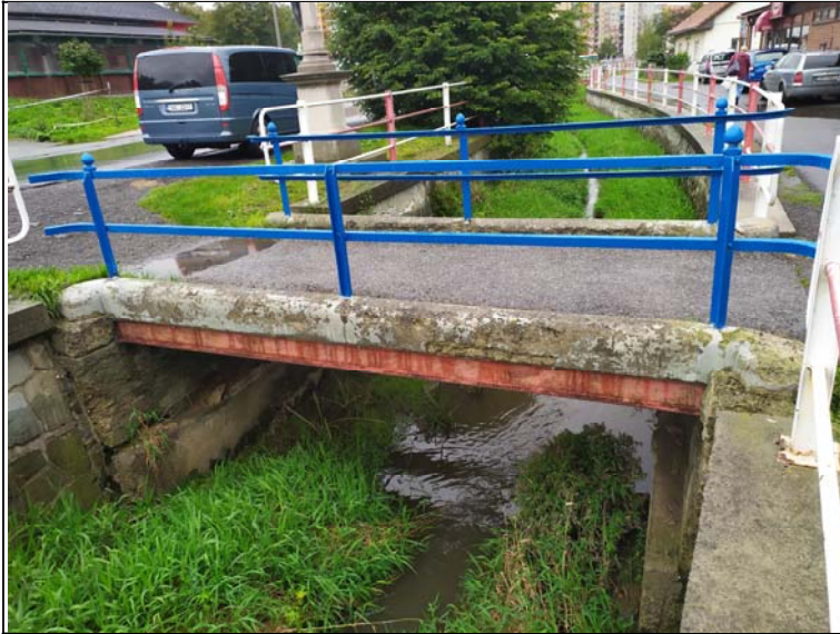
Boční pohled k opěře 1 (pravý)
