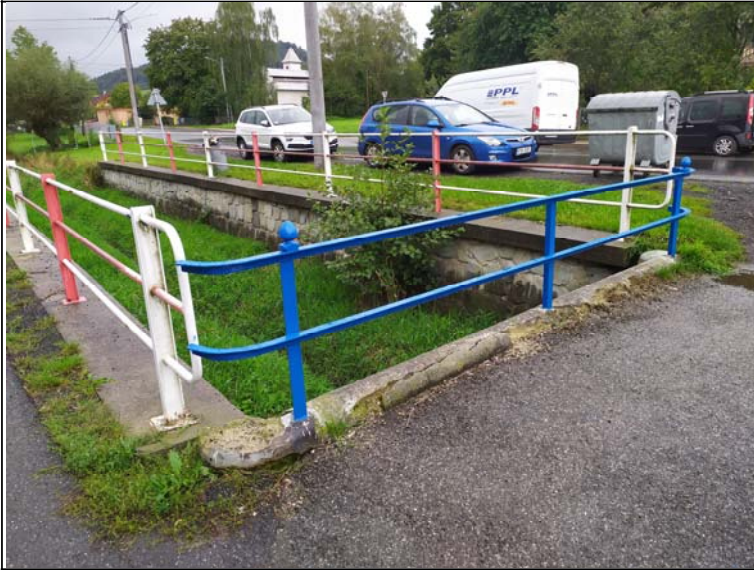
Pravé zábradlí - s pohledem k opěře 1
