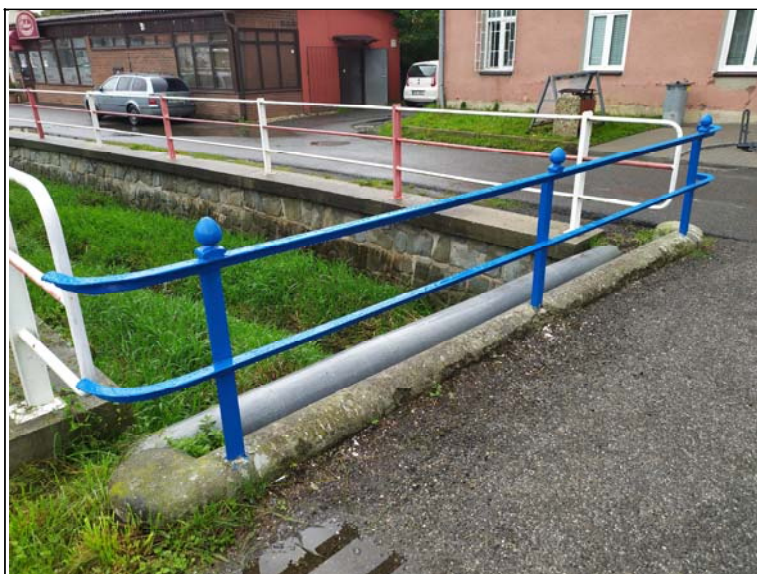
Levé zábradlí - s pohledem k opěře 2
