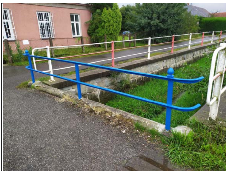
Pravé zábradlí - s pohledem k opěře 2
