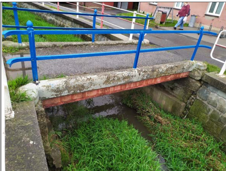
Boční pohled k opěře 2 (pravý)
