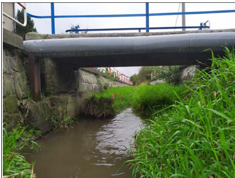
Prostorové uspořádání pod mostem (povodní)
