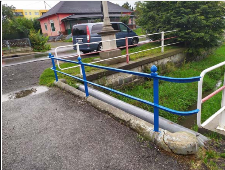
Levé zábradlí - s pohledem k opěře 1
