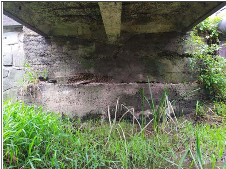
Pohled na opěru 1
