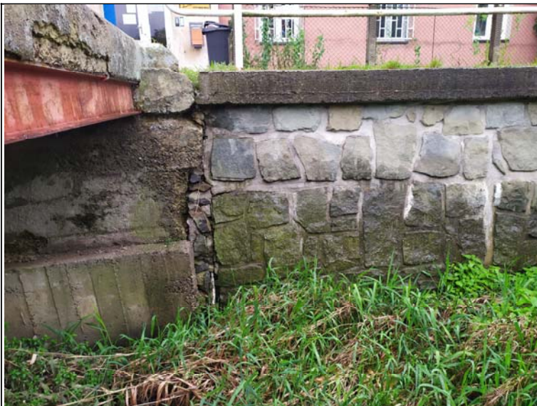
Pohled na pravé křídlo opěry 2
