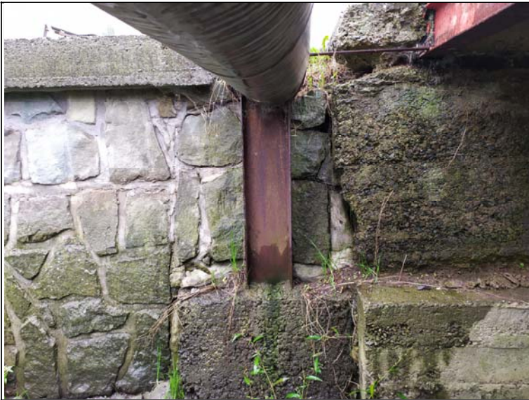
Pohled na levé křídlo opěry 2
