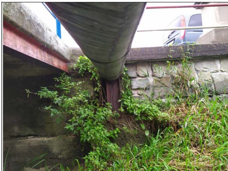
Pohled na levé křídlo opěry 1
