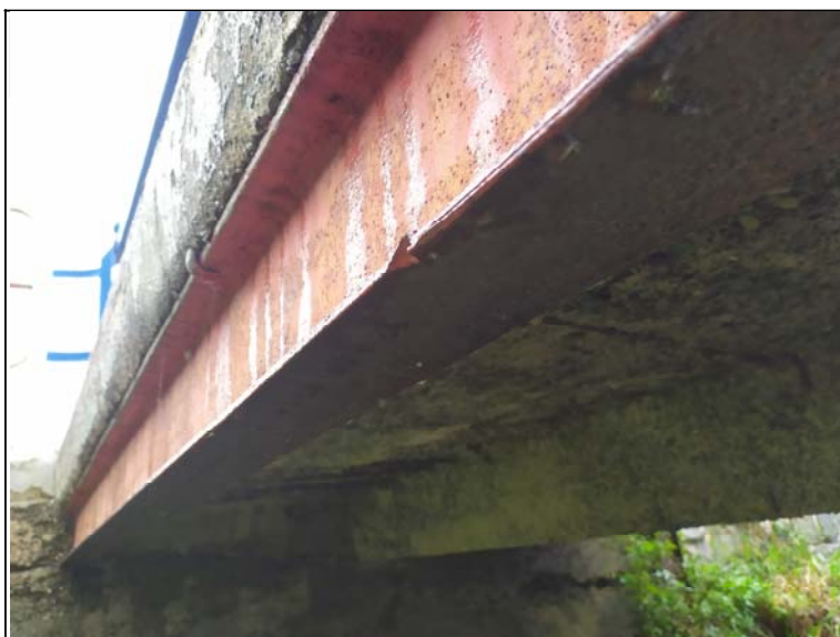
Podhled nosné konstrukce - s pohledem k opěře 1, pravý bok
