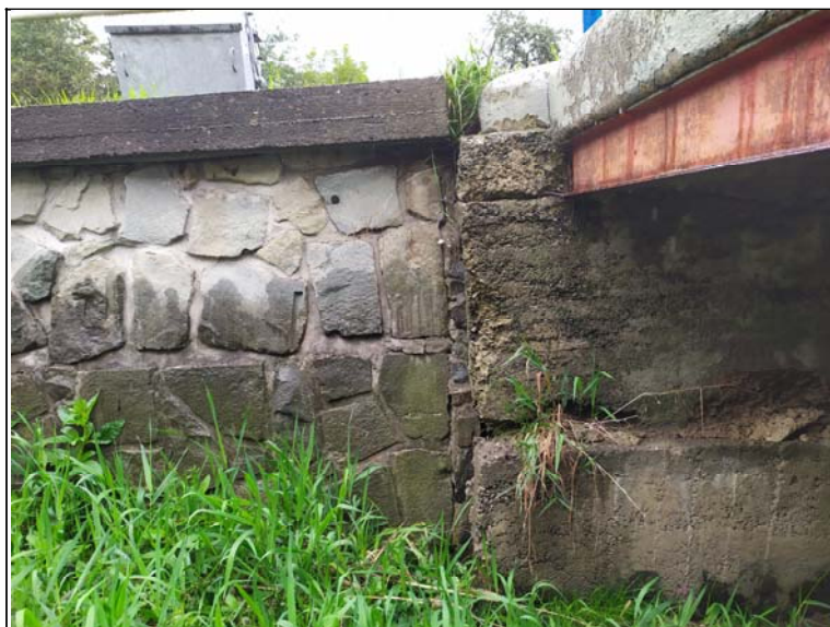
Pohled na pravé křídlo opěry 1
