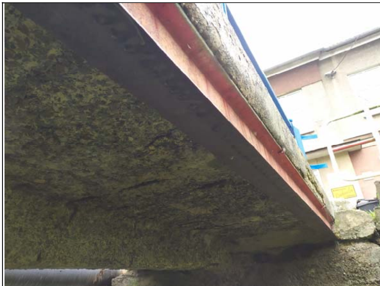
Podhled nosné konstrukce - s pohledem k opěře 2, pravý bok
