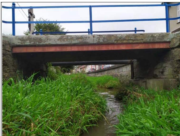
Prostorové uspořádání pod mostem (protivodní)
