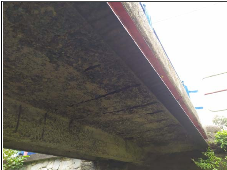
Podhled nosné konstrukce - s pohledem k opěře 1, levý bok
