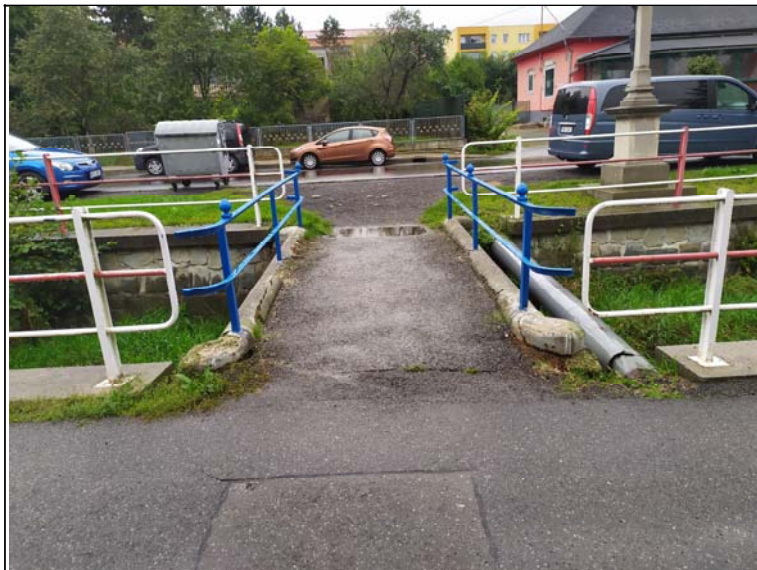
Prostorové uspořádání na mostě (proti směru staničení)
