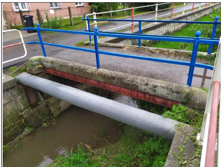
Boční pohled k opěře 2 (levý)
