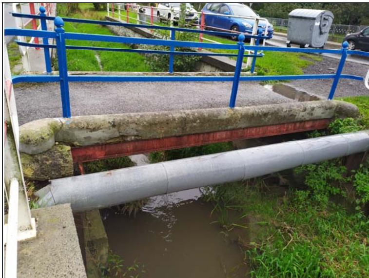
Boční pohled k opěře 1 (levý)
