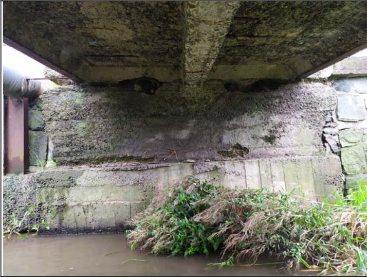
Pohled na opěru 2
