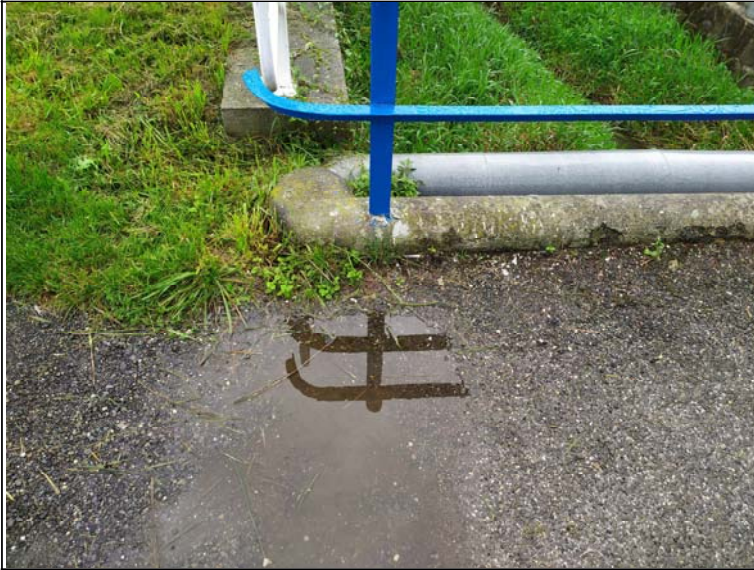
Pohled na dilataci opěry 1
