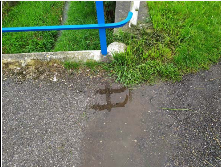
Pohled na dilataci opěry 1
