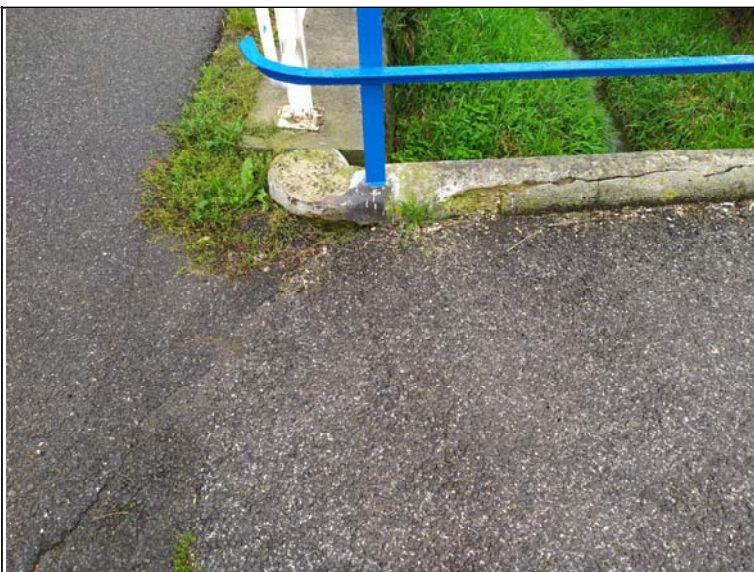
Pohled na dilataci opěry 2
