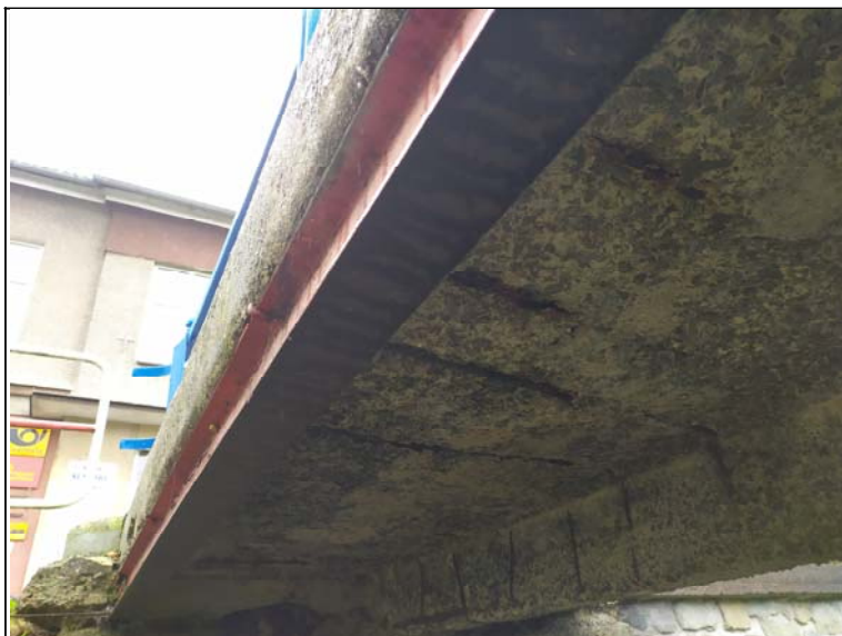
Podhled nosné konstrukce - s pohledem k opěře 2, levý bok
