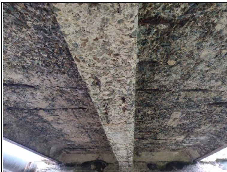
Podhled nosné konstrukce - s pohledem k opěře 2
