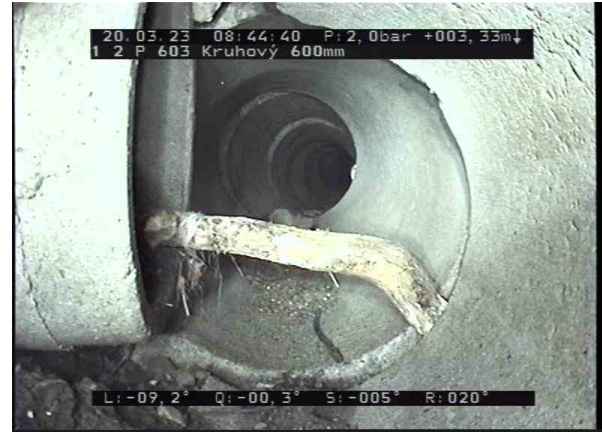
1-2_779abc41-c89f-466d-8bd8-7e026a12ed55_20230320_084516_549.jpg, 00:01:54, 3.33m Přerušení inspekce, překážka / kořen a kamení, kamera dál nejede
