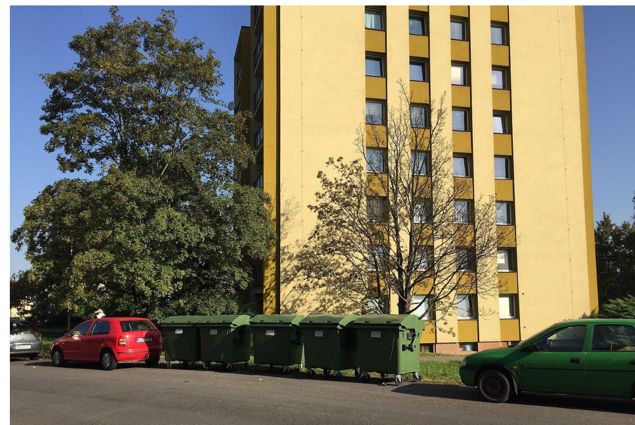
Dům č.p.242/42 v ul. Revoluční po kompletní revitalizaci
