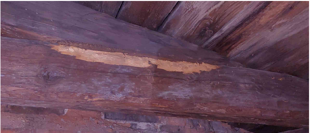
Obr. 5: 16B, VZI. napadení dřevokazným hmyzem tesaříkem
