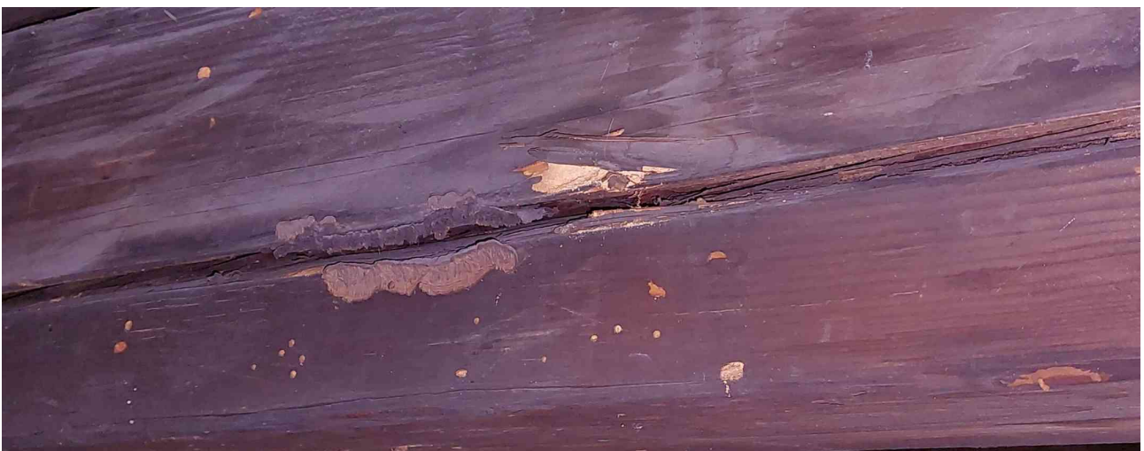
Obr. 6: 2A, VZI. plodnice dřevokazné houby trámovky
