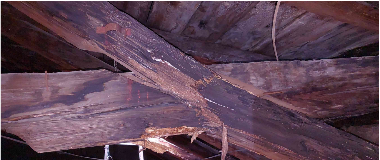
Obr. 4: 7B, degradace prvků VZI. a KL
