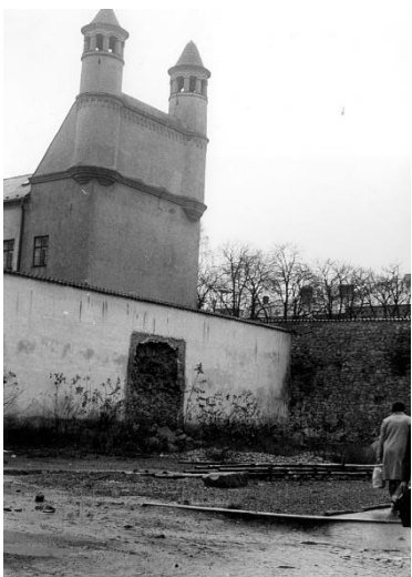
V roce 1961 nádvorní zeď, vzniklá zbouráním staveb v dnešní Lidické ulici ještě bez dokončeného prostupu (dnes náměstí V. Havla).
