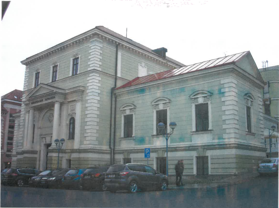
Pohled na původní část budovy se vstupem do divadla.
