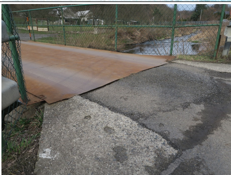
Napojení mostovkového plechu na přechodovou oblast OP1. Napojení na silnici III. třídy.
