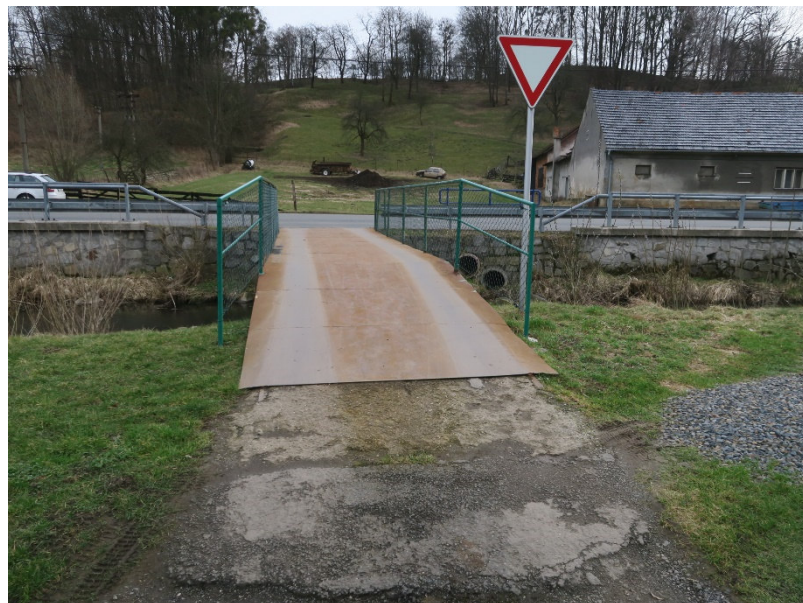
Pohled na most proti směru staničení.
