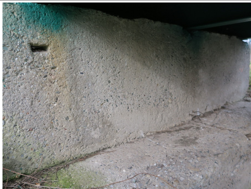
Detail středového pilíře.
