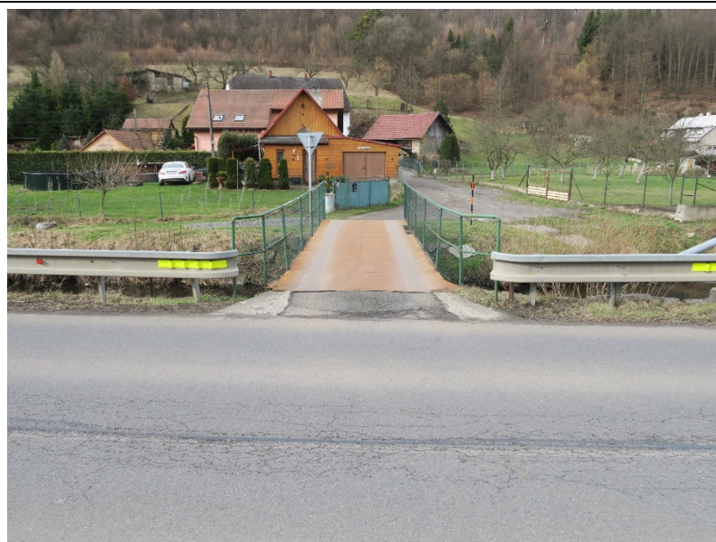
Pohled na most ve směru staničení.
