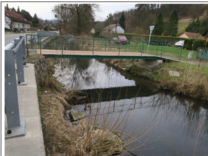
Pohled na most proti směru toku Jičínky. Pohled zprava.
