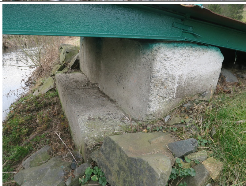
Středový pilíř, pohled zprava.
