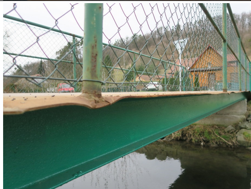
Typické kotvení sloupku zábradlí.
