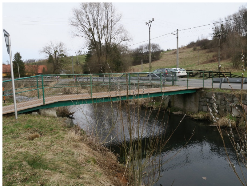
Pohled na most ve směru toku Jičínky. Pohled zleva.
