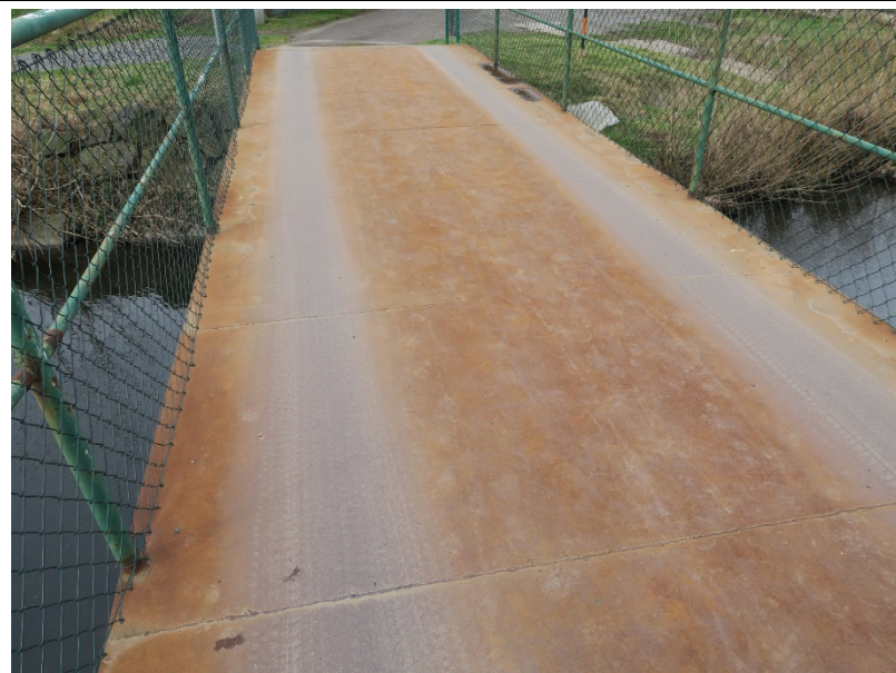
Pohled na mostovku.
