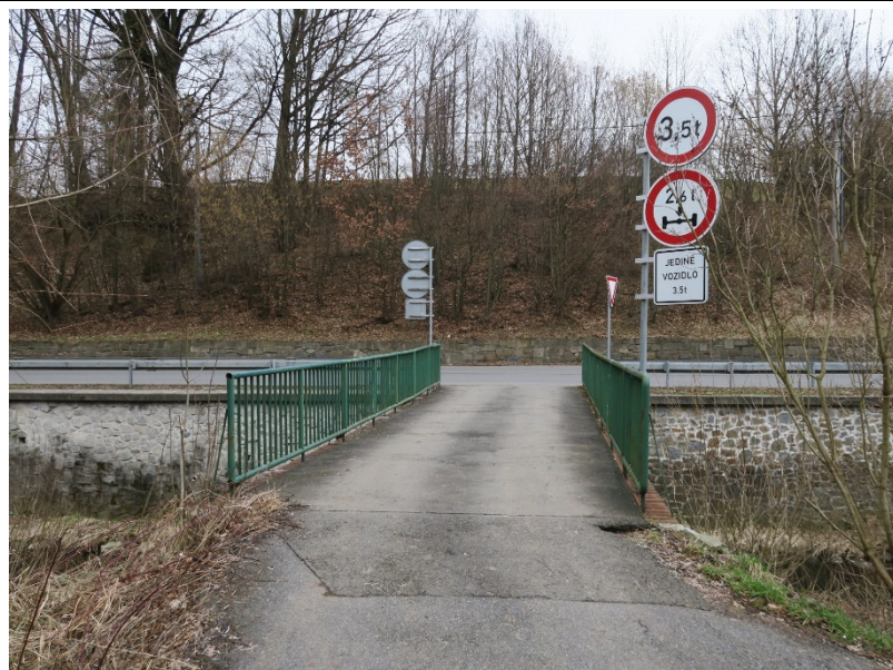
Pohled na most proti směru staničení.
