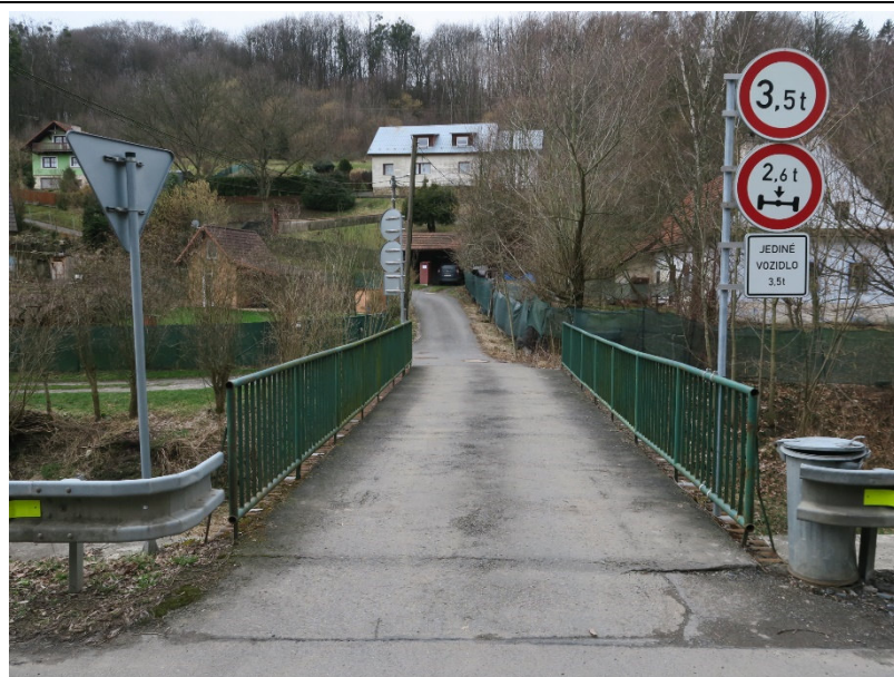
Pohled na most ve směru staničení.
