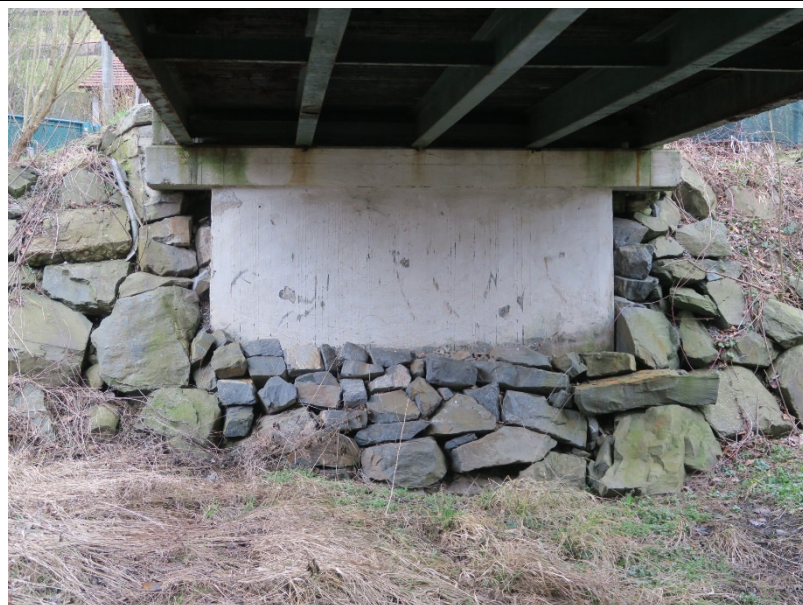
Pohled na OP2 vč opevnění.
