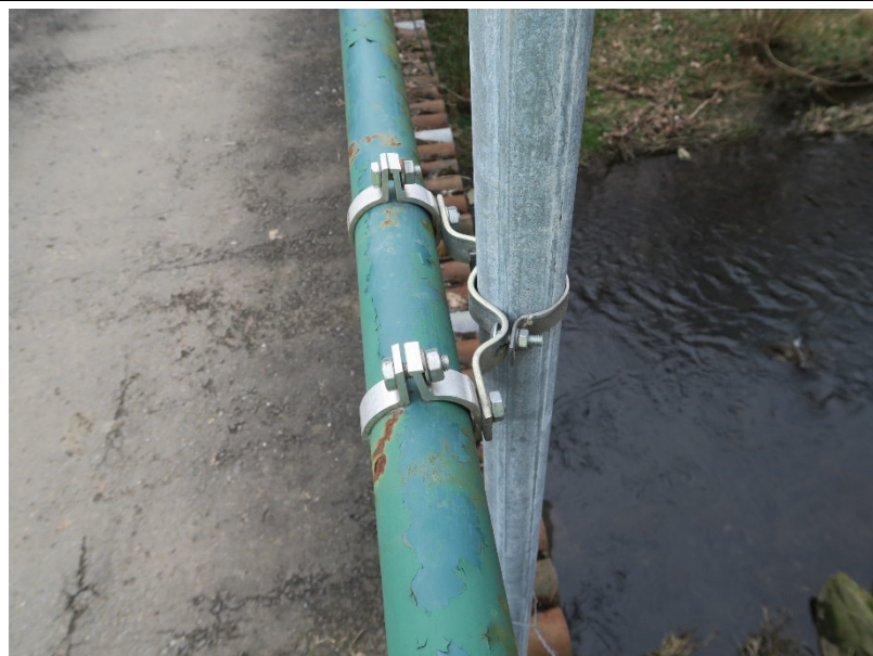
Kotvení sloupku DZ na zábradlí.
