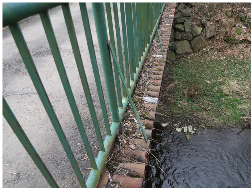
Uchycení zábradlí na mostě.
