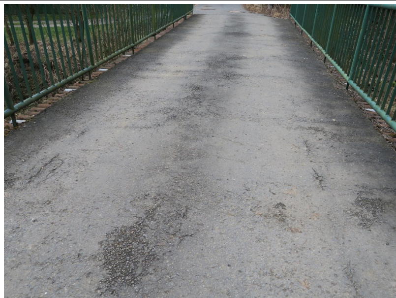
Pohled na průjezdný profil a vozovku.
