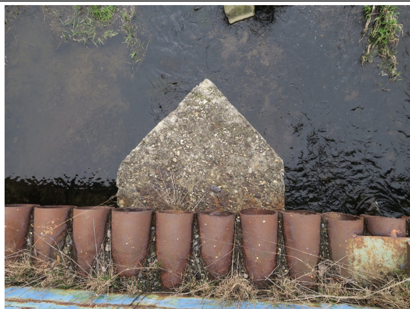
Středový pilíř půdorysně vytvarován jako ledolam.
