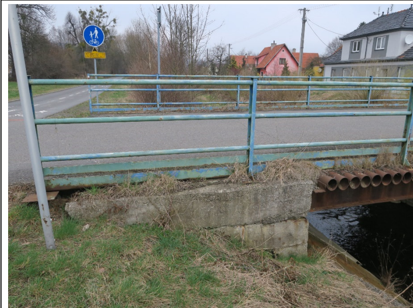
Křídlo a část římsy nad opěrou 1 zprava.
