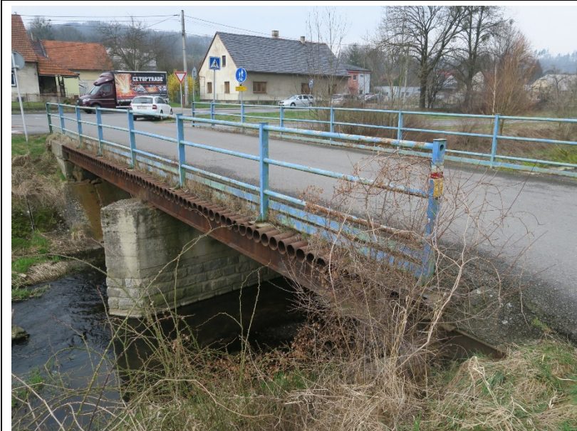
Pohled na most proti směru staničení.
