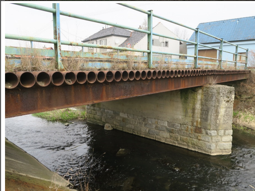
Pohled na most zprava. Středový pilíř a 1. mostní pole.
