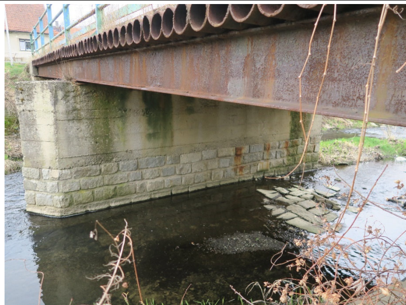
Vedení plynovodu vlevo.
