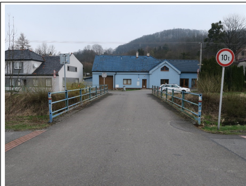
Pohled na most ve směru staničení.
