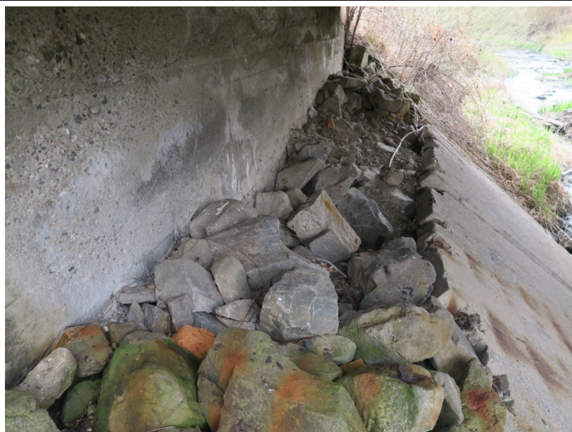
Kamenný zához na vrcholu opevnění OP3.
