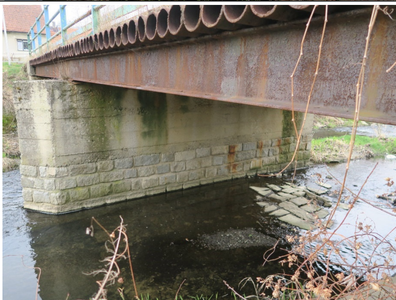
Pohled na most zprava. Středový pilíř a 2. mostní pole.
