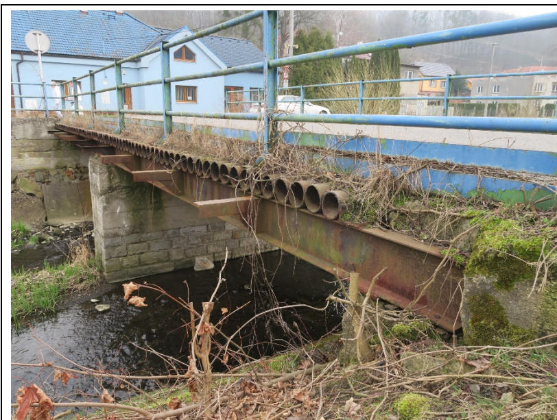
Boční pohled na most zleva. Trubková mostovka, do které je kotveno zábradlí.
