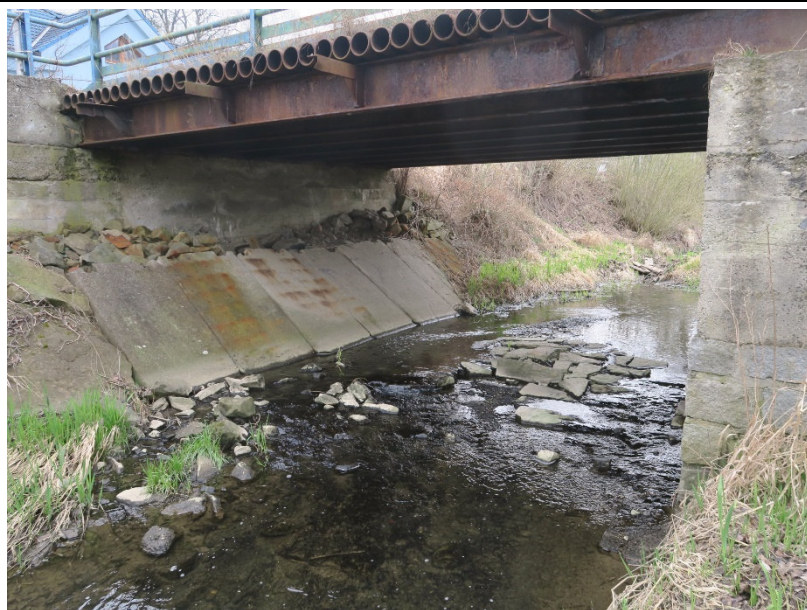
Opevnění OP3 a pohled pod 2. mostní pole.
