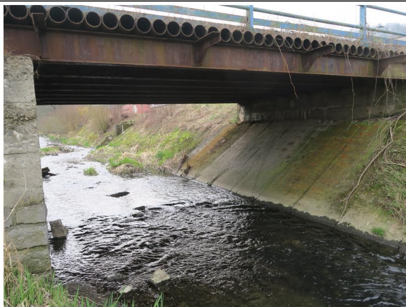
Pohled pod 1. mostní pole.
