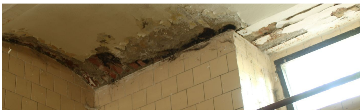
Obr 21: Plodnice v suterénu Vily 1, 1.PP-1.003
