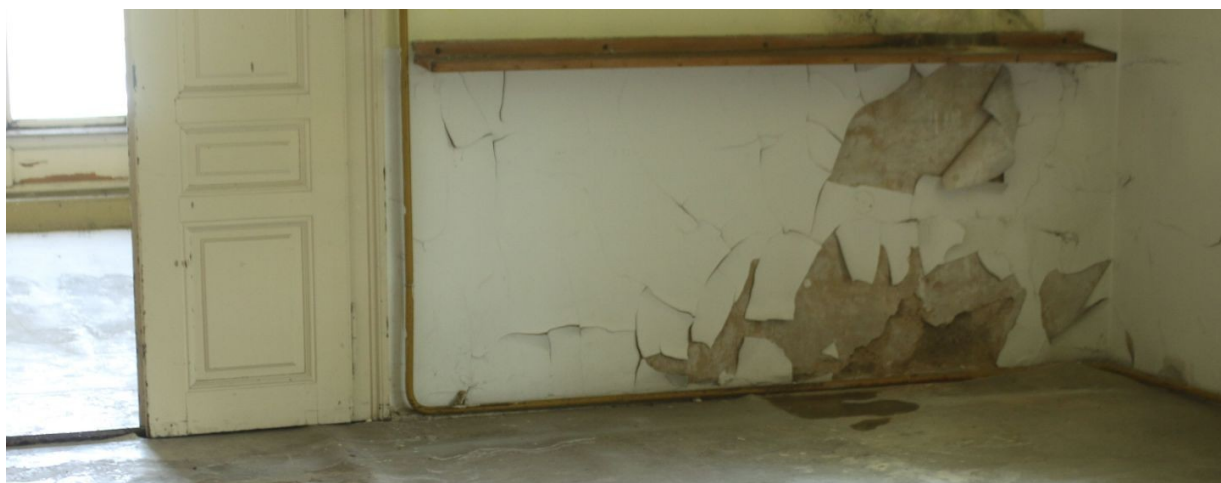
Obr 24: Zatékání užlabím, Vila 1, 3.NP-1.304
