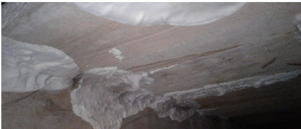
Obr 17: Vnitřní prostor stropu u sondy S11 (plodnice dřevomorky Serpula)
