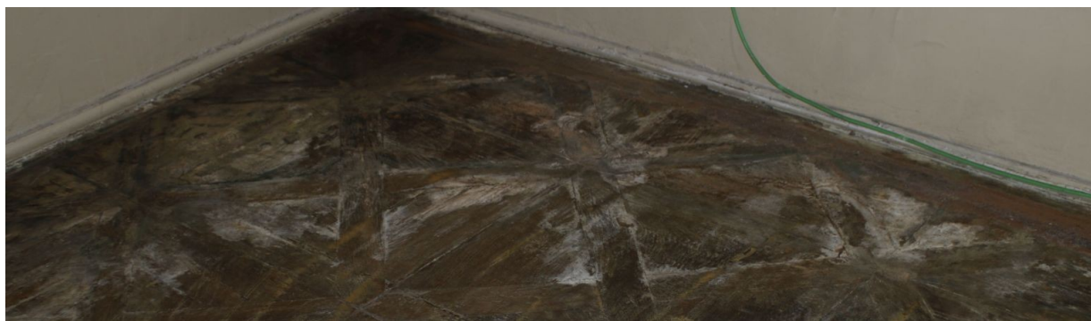
Obr 22: Napadení dřevomorkou (Serpula), Vila 1, INP-1.118
