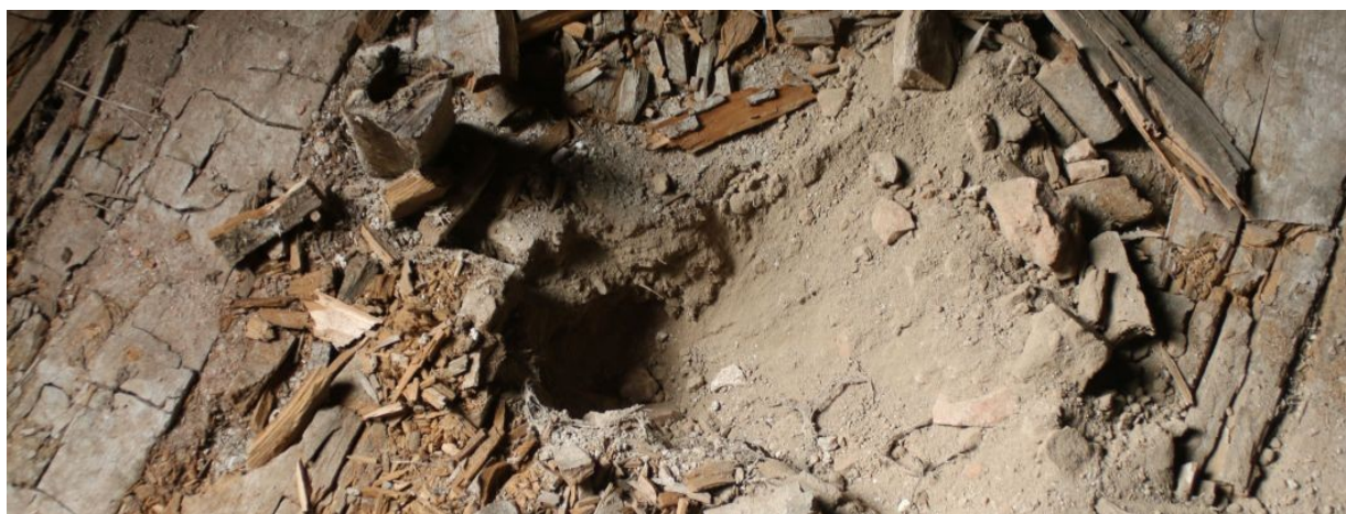
Obr 6: Napadení dřevomorkou (Serpula), Vila 2, 1.NP-2.110
