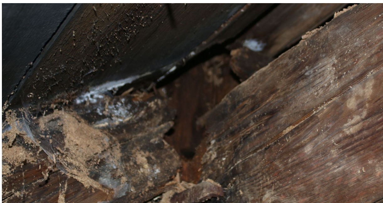
Obr 27: Detail na napadení sloupku, Vila 1, PŮDA 4.NP
