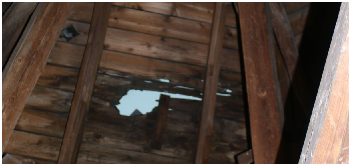
Obr 29: Poškození žeber a bednění kopule, Vila 1
