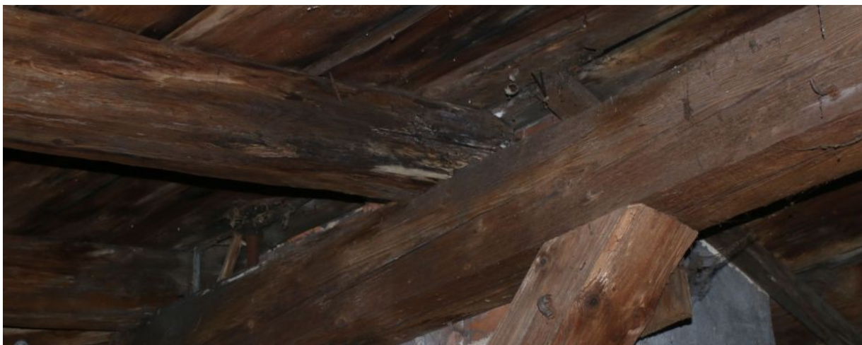
Obr 18: PŮDA 4.NP zatékání u hřebene Vila 2
