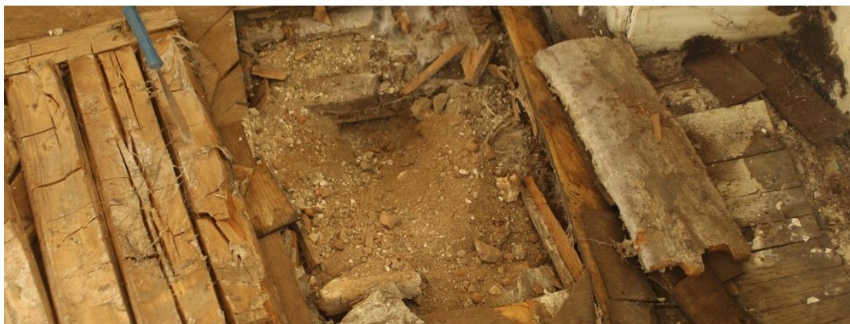
Obr 5: Napadení dřevomorkou (Serpula), Vila 2, 1.NP-2.111
