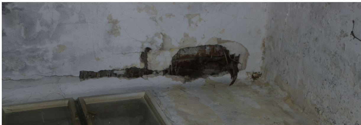
Obr 23: Zatékání u točitého schodiště, Vila 1, INP-1.106
