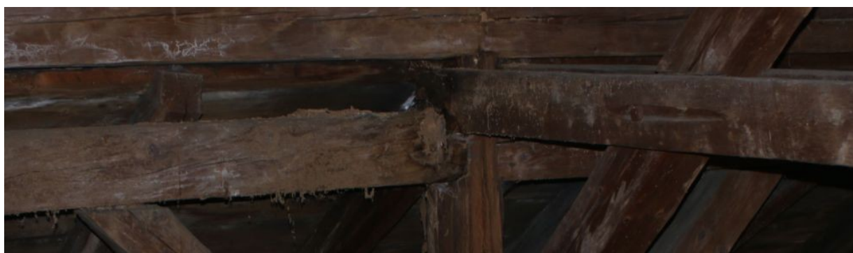
Obr 26: Napadení sloupku, vaznice a kleštin, Vila 1, PŮDA 4.NP
