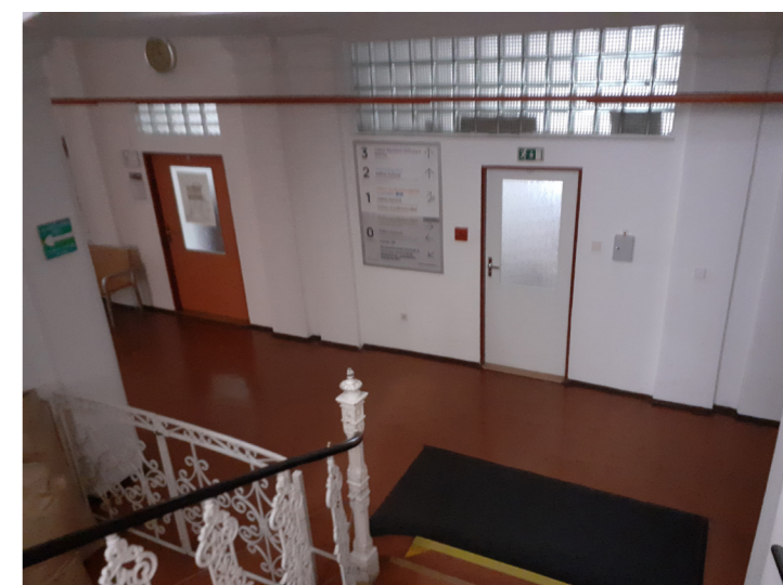
Místo původního vstupu do budovy soudu
