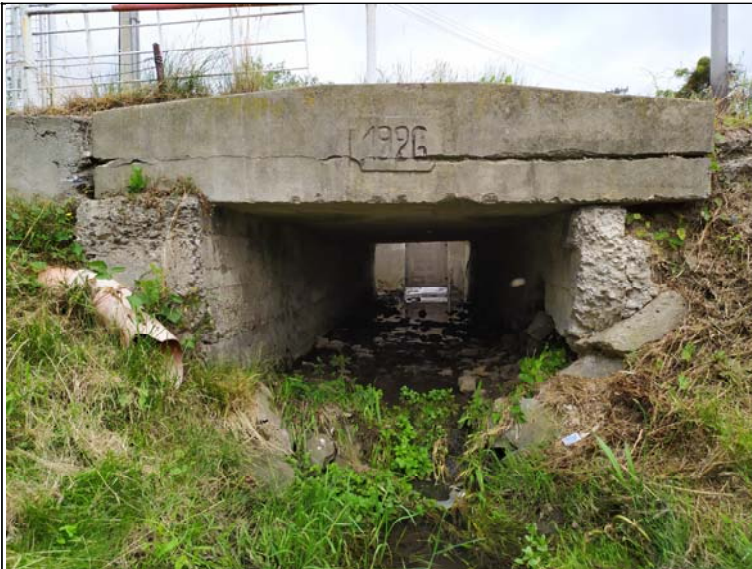
Prostorové uspořádání pod mostem (povodní)
