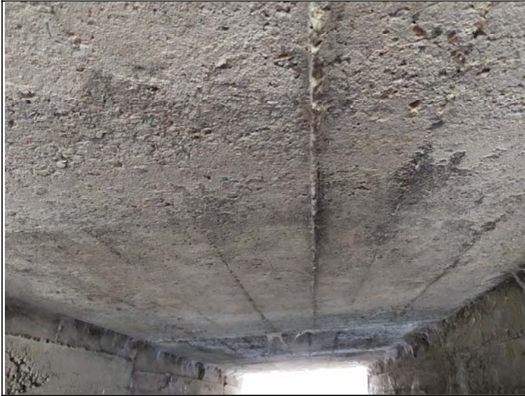
Podhled nosné konstrukce
