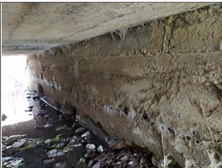
Pohled na opěru 1
