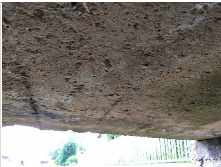
Podhled nosné konstrukce
