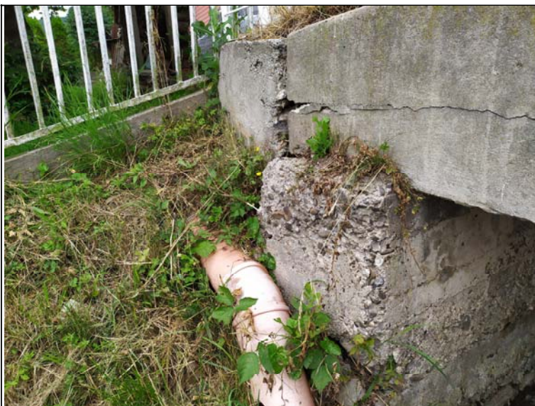
Pohled na levé křídlo opěry 2
