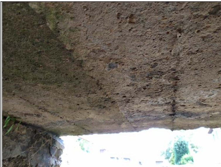
Podhled nosné konstrukce
