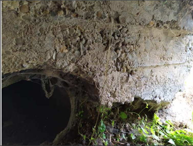
Pohled na opěru 1
