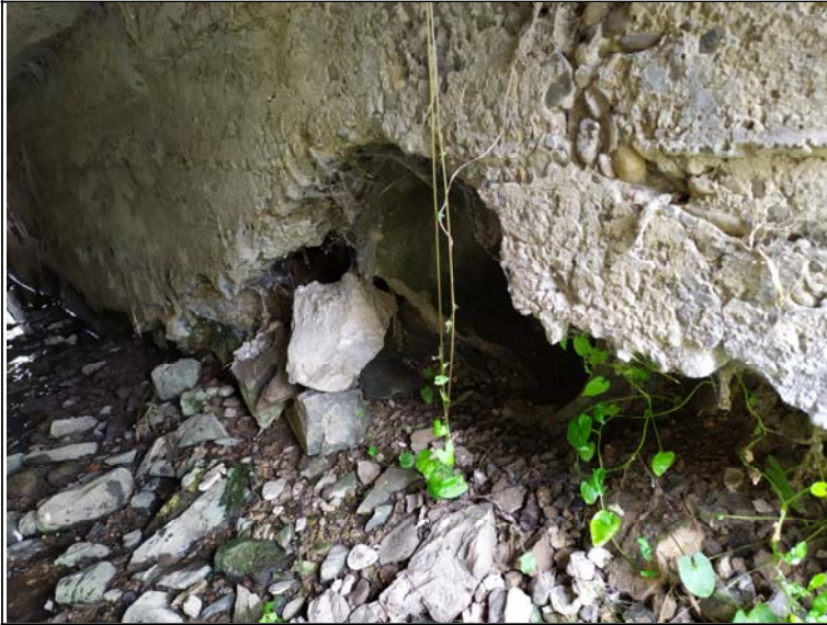
Kanalizace v opěře 1
