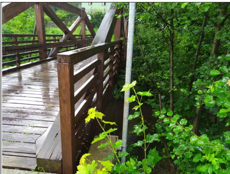
Pohled na levou plentovací zídku opěry 2
