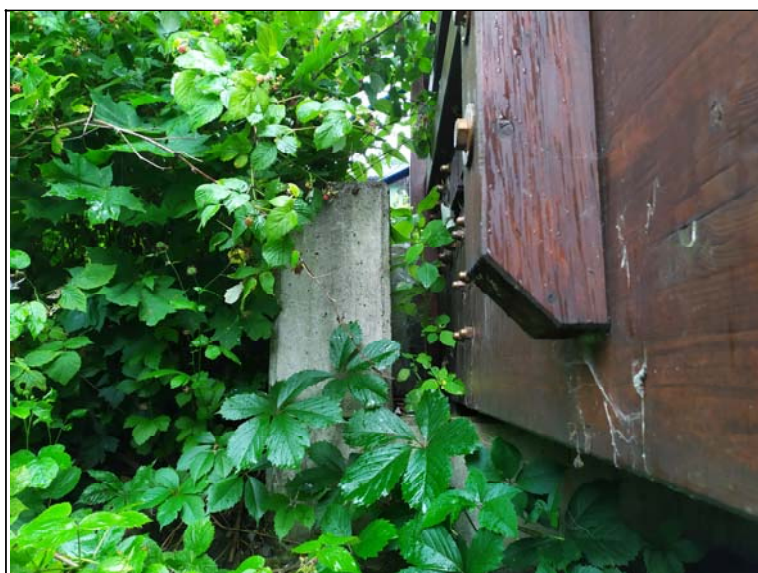
Pohled na pravou plentovací zídku opěry 1
