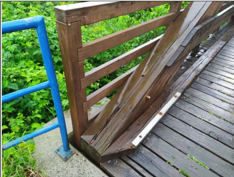
Detail vzpěry pravého věšadla u opěry 2
