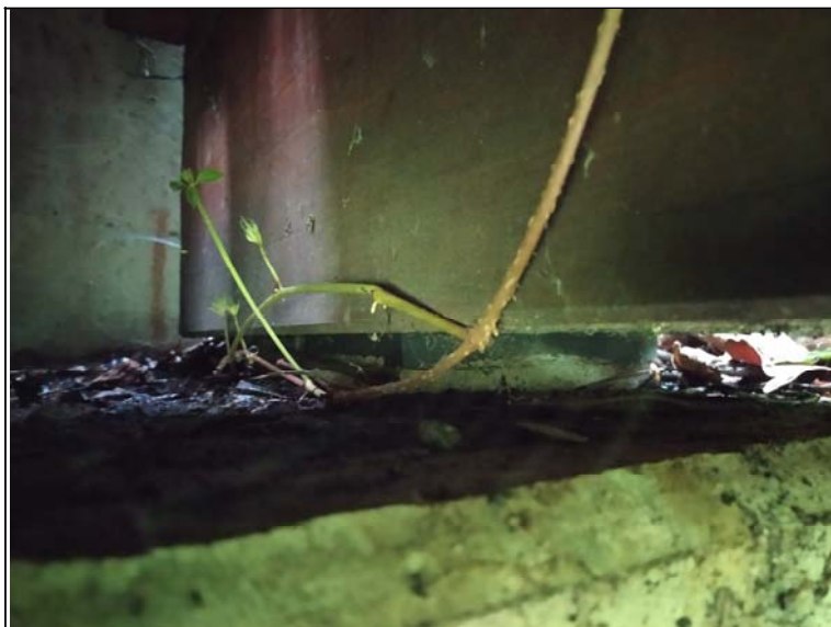
Uložení nosníku na opěře 1
