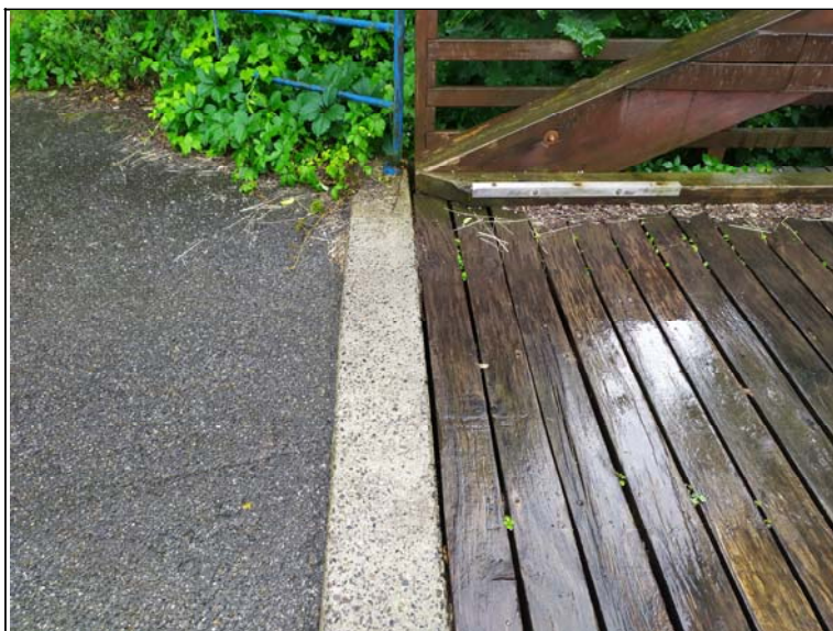
Dilatace nad opěrou 1
