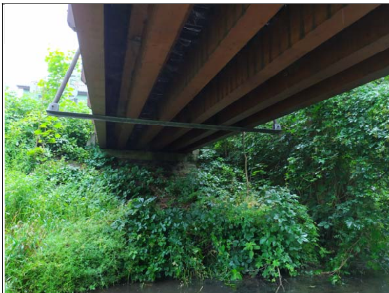
Podhled nosné konstrukce - s pohledem k opěře 1, pravý nosník
