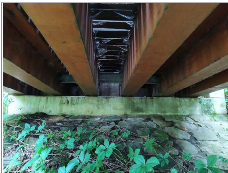
Pohled na opěru 1
