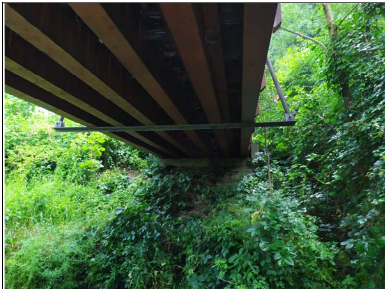
Podhled nosné konstrukce - s pohledem k opěře 1, levý nosník
