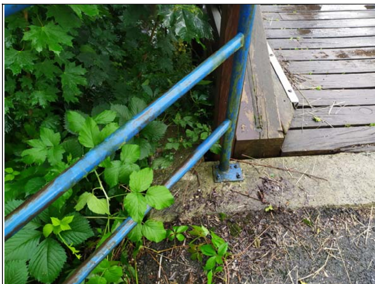
Pohled na levou plentovací zídku opěry 1
