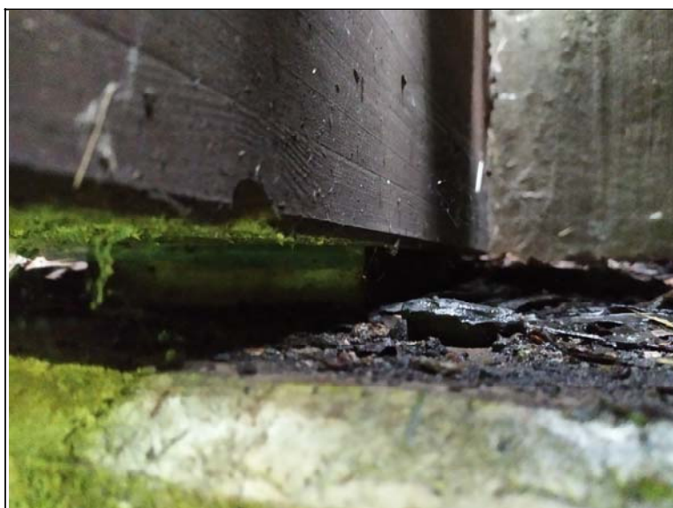
Uložení nosníku na opěře 1
