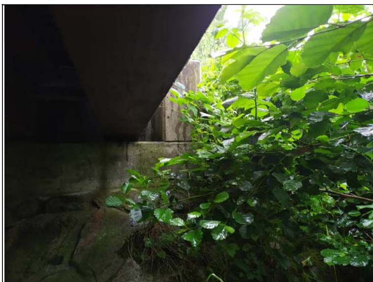
Pohled na pravou plentovací zídku opěry 2
