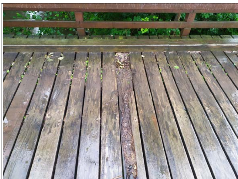
Pohled na mostovku
