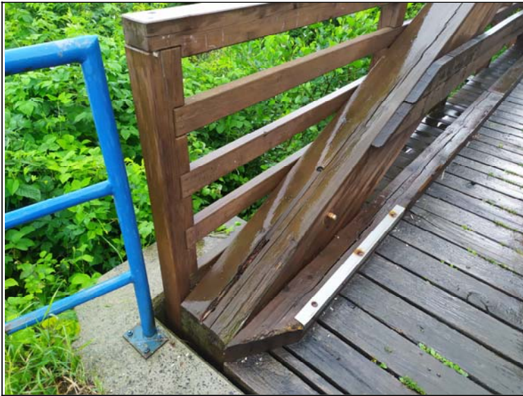
Pohled na pravou plentovací zídku opěry 2
