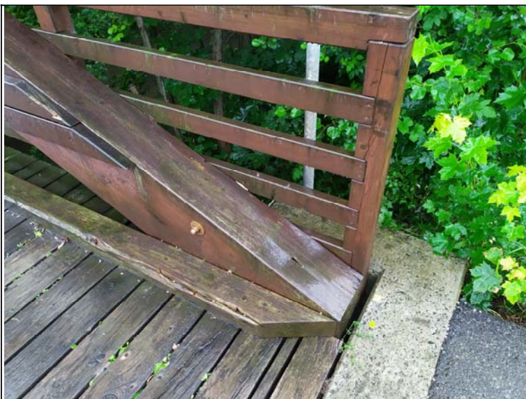
Detail vzpěry levého věšadla u opěry 2
