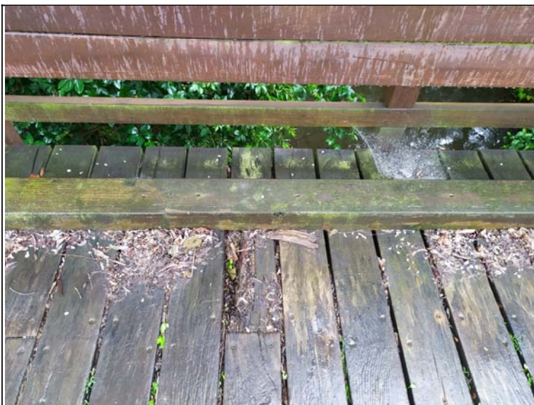
Pohled na mostovku
