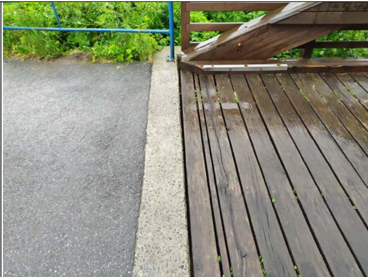
Dilatace nad opěrou 2
