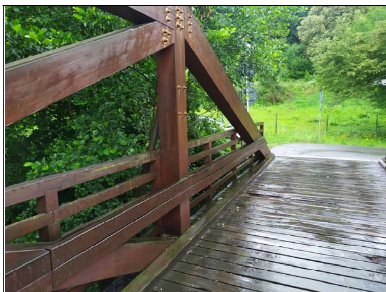
Pohled na mostovku Detail svodnice
