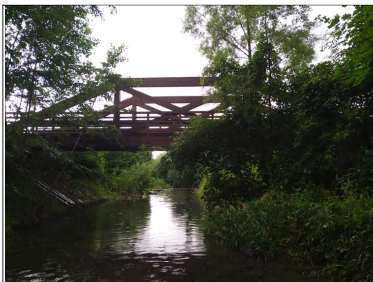
Prostorové uspořádání pod mostem (protivodní)
