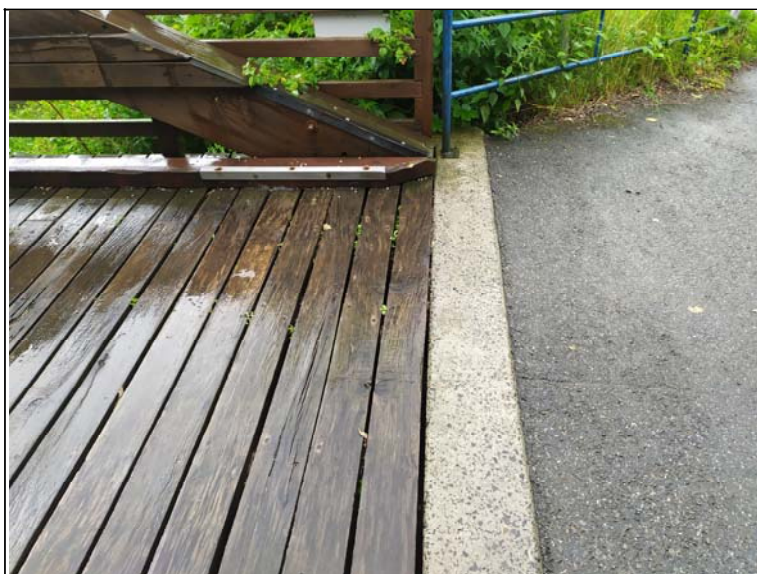
Dilatace nad opěrou 1
