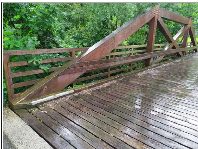
Levé věšadlo se zádržným systémem - s pohledem o opěře 2
