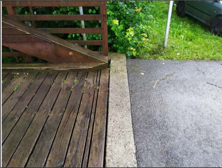
Dilatace nad opěrou 2
