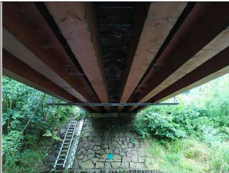
Podhled nosné konstrukce - s pohledem k opěře 2
