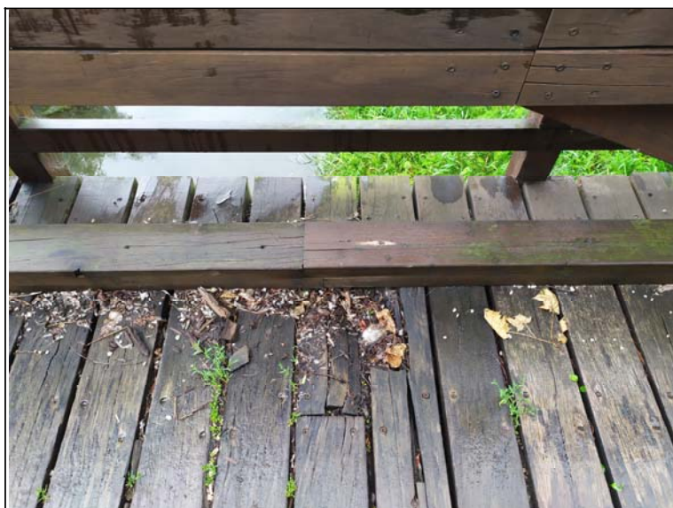
Pohled na mostovku
