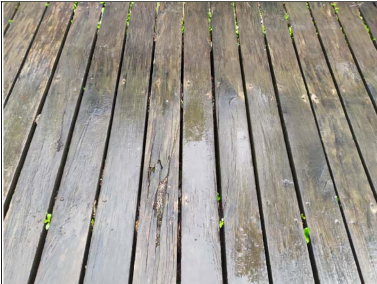
Pohled na mostovku
