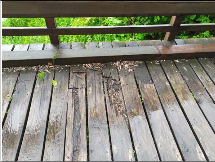
Pohled na mostovku
