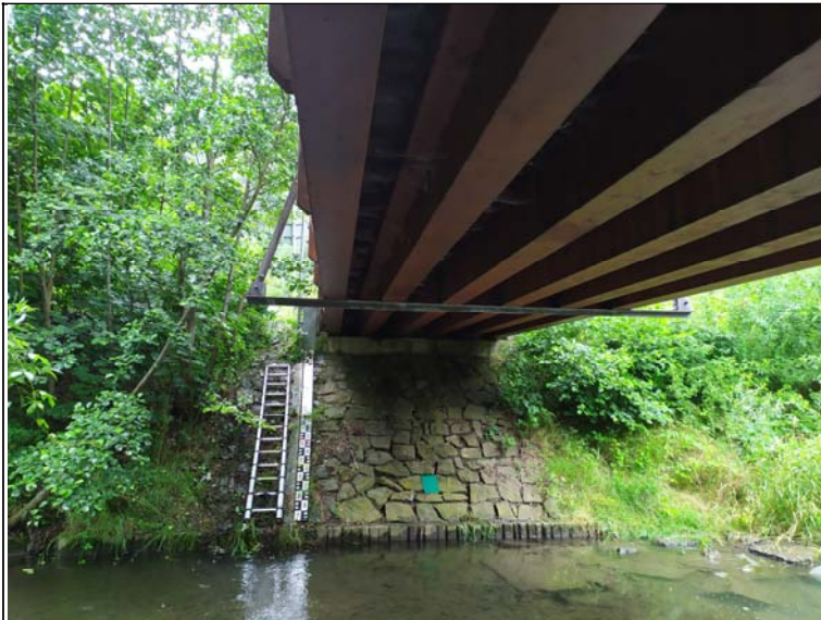
Podhled nosné konstrukce - s pohledem k opěře 2, levý nosník
