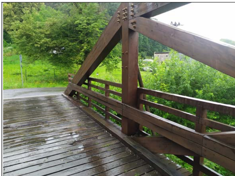
Pohled na mostovku Detail svodnice
