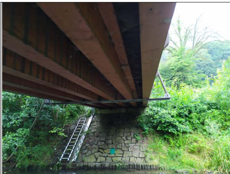
Podhled nosné konstrukce - s pohledem k opěře 2, pravý nosník
