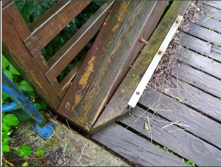
Detail vzpěry levého věšadla u opěry 1
