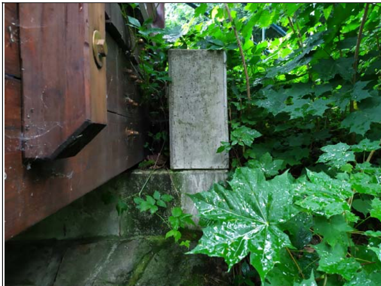
Pohled na levou plentovací zídku opěry 1
