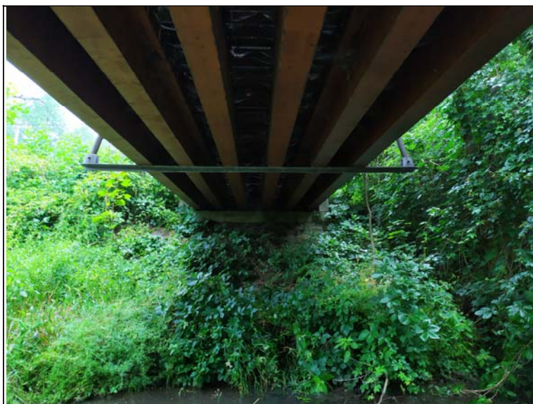
Podhled nosné konstrukce - s pohledem k opěře 1
