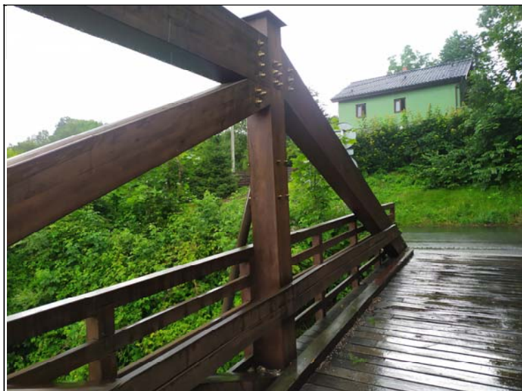
Pohled na mostovku Detail svodnice
