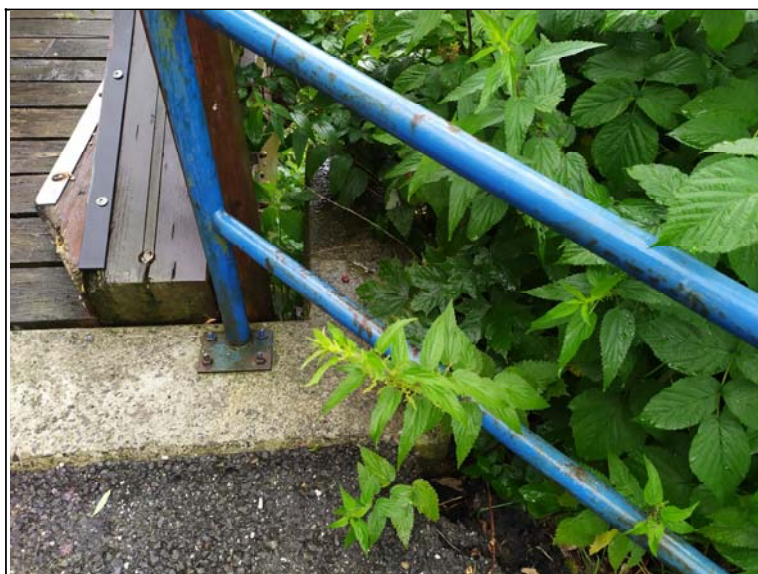
Pohled na pravou plentovací zídku opěry 1
