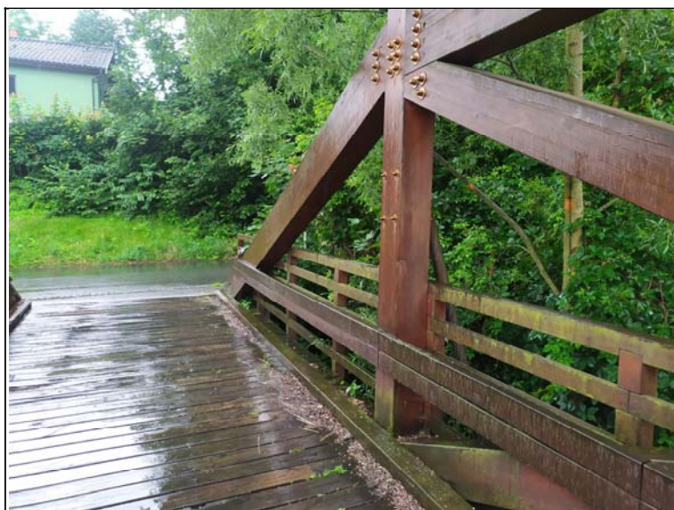
Pohled na mostovku Detail svodnice
