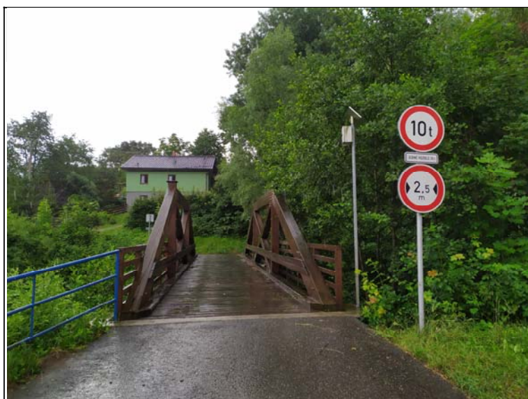
Prostorové uspořádání na mostě (proti směru staničení)
