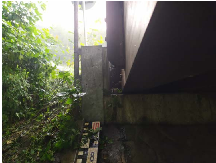
Pohled na levou plentovací zídku opěry 2
