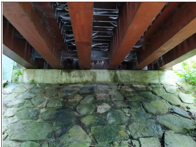
Pohled na opěru 2
