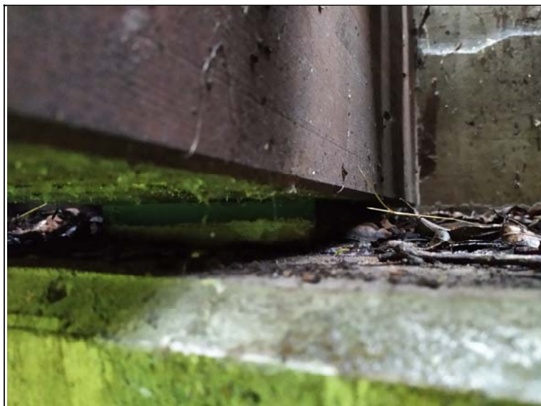
Uložení nosníku na opěře 1
