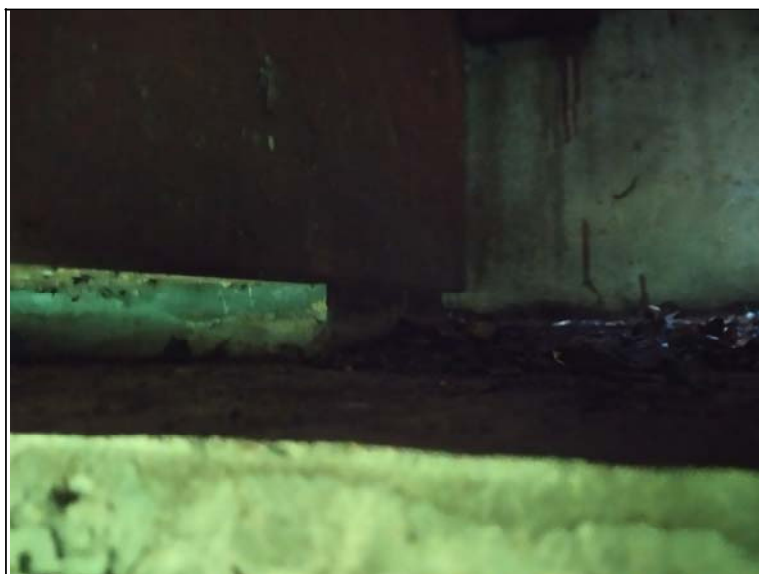
Uložení nosníku na opěře 1
