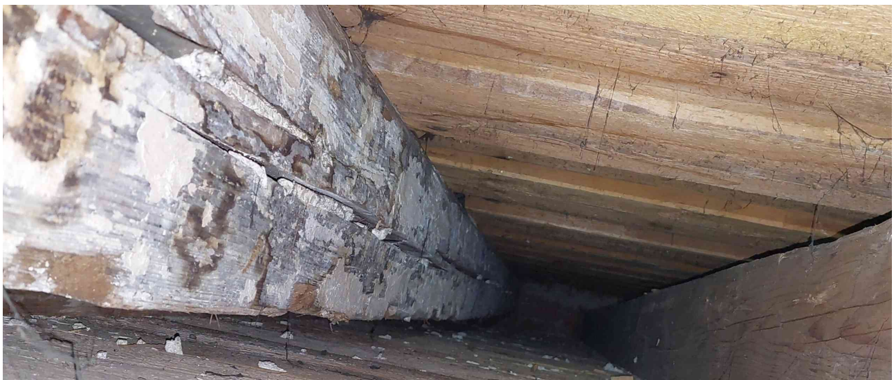
Obr. 8: sonda S7, druhotně použitý stropní trám
