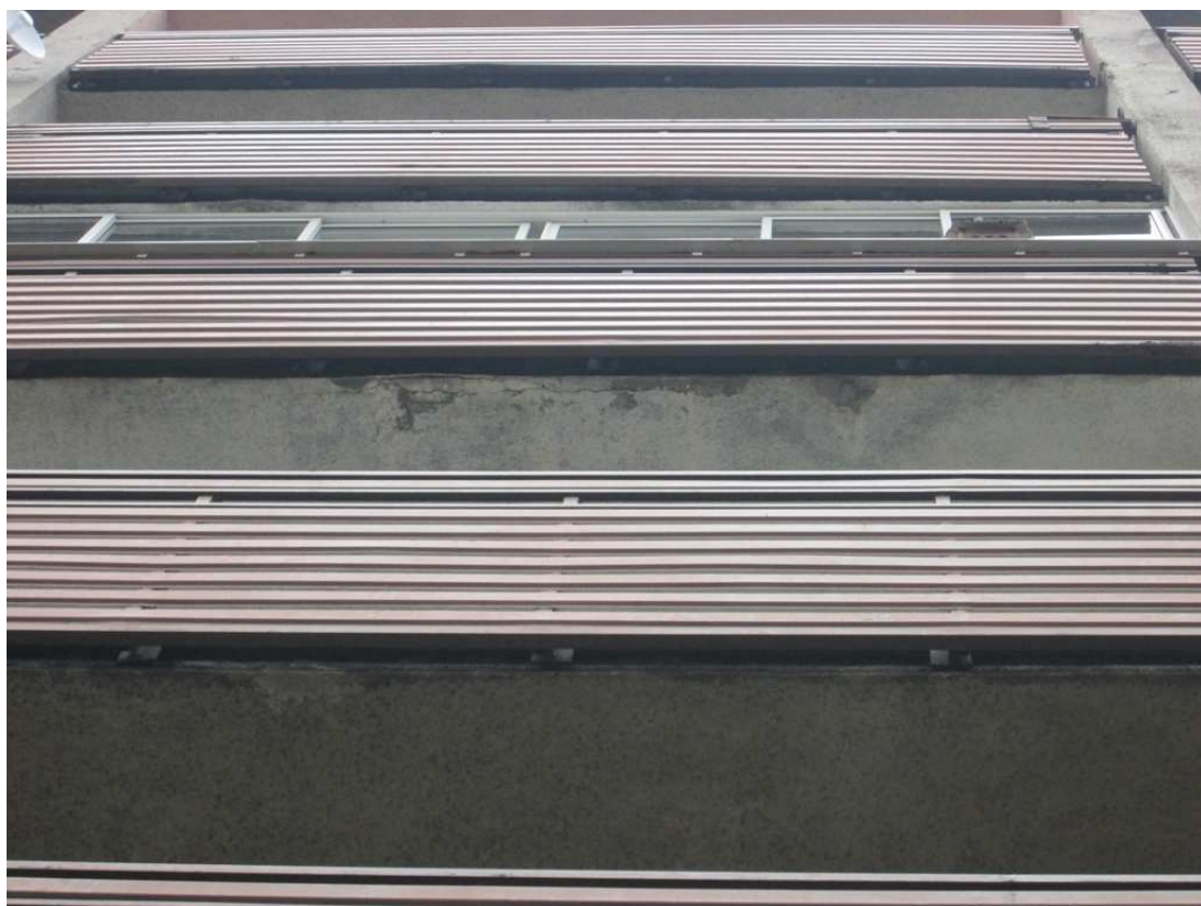
[04.] Poruchy lodžiových desek v místech jejich vnější hrany (tzv. okapového nosu)
