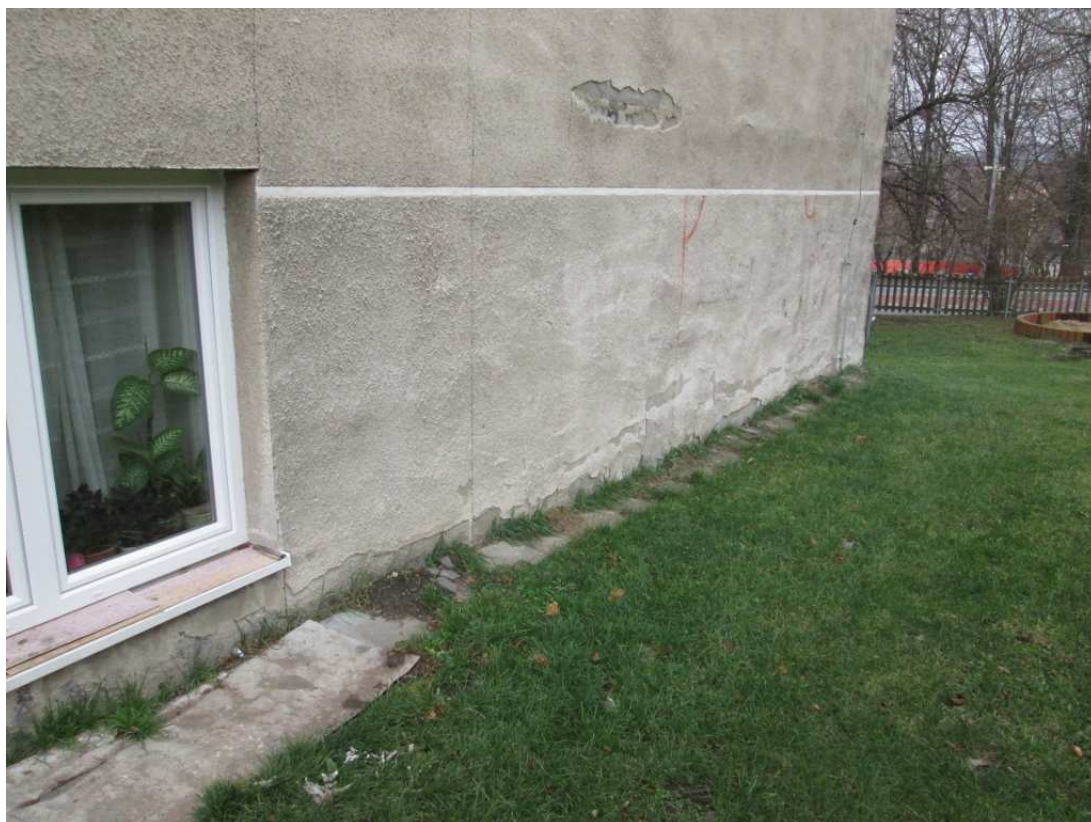
[01.] Poruchy omítky fasády v její ploše
