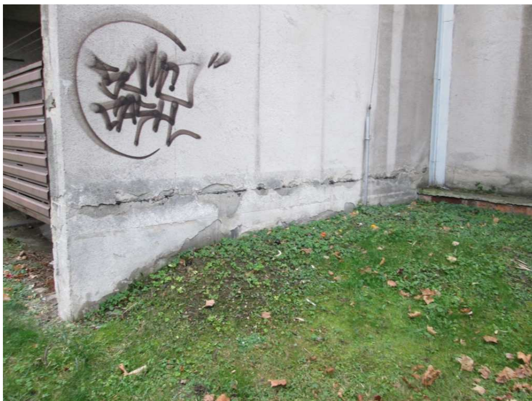
[02.] Poruchy omítky fasády v plochách situovaných nízko nad terénem
