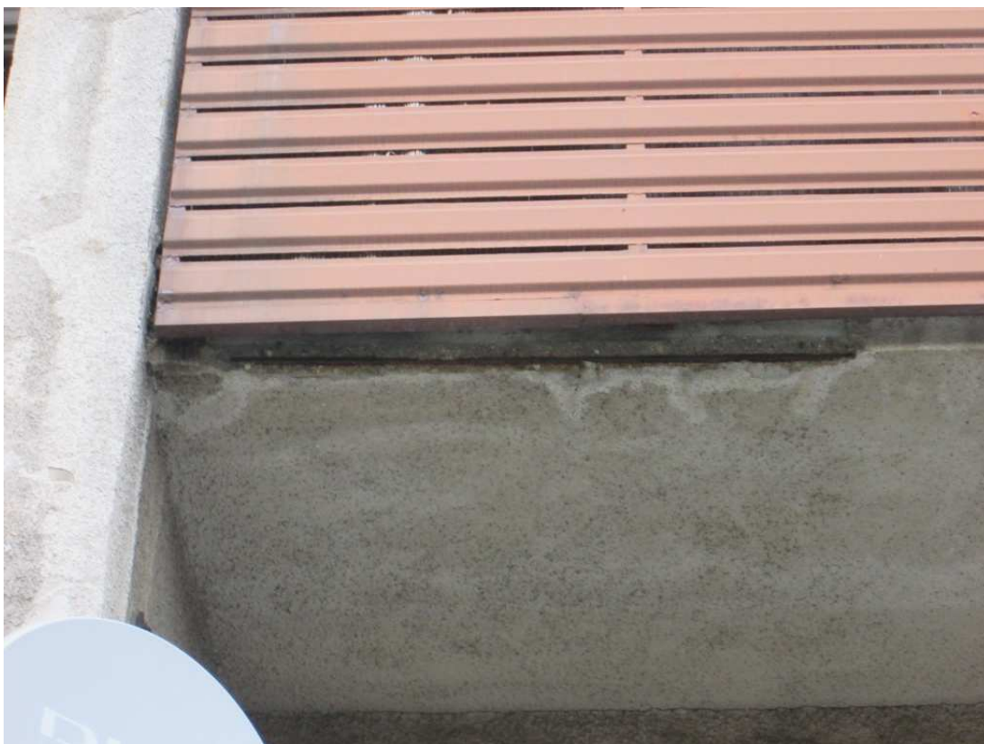
[05.] Poruchy lodžiových desek v místech jejich vnější hrany (tzv. okapového nosu)
