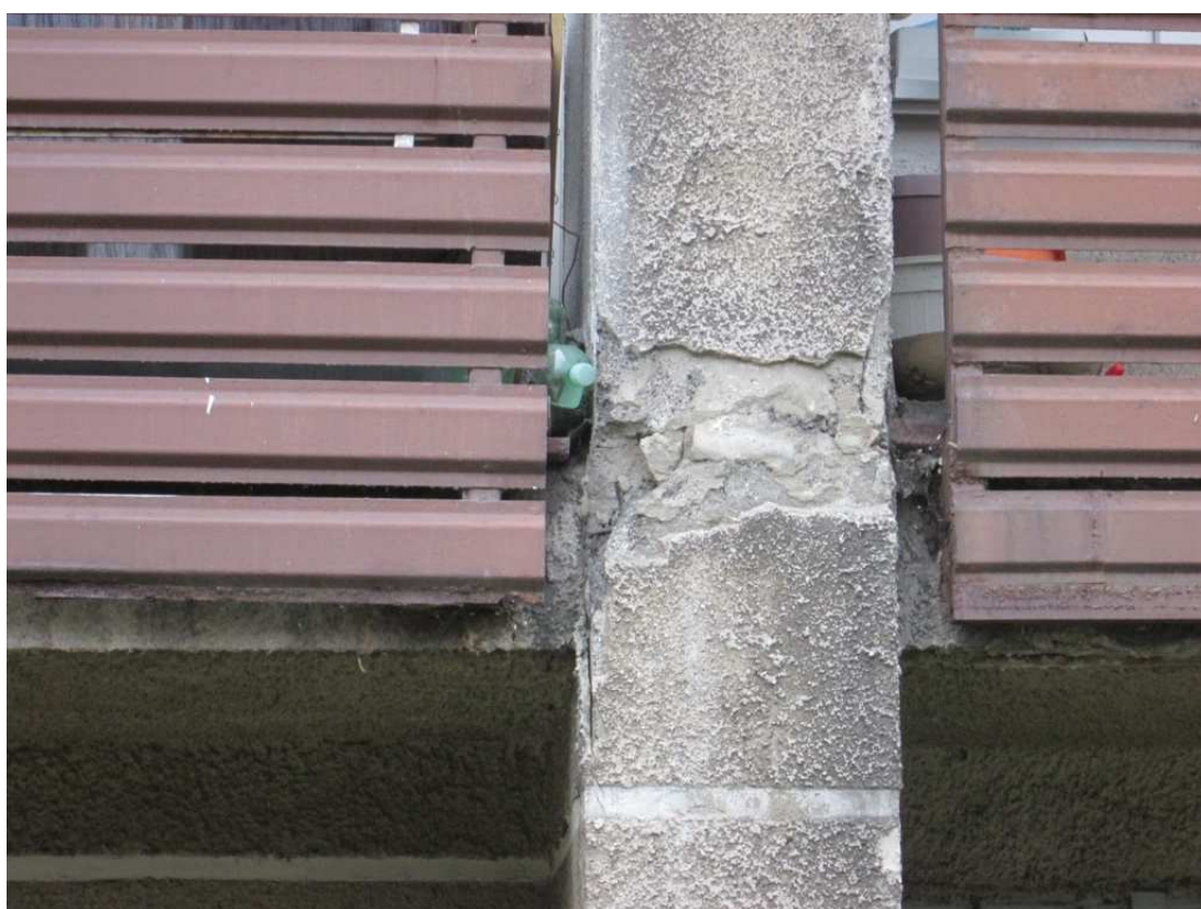
[08.] Poruchy v místech kotvení ocelového zábradlí lodžii do nosných lodžiových stěn
