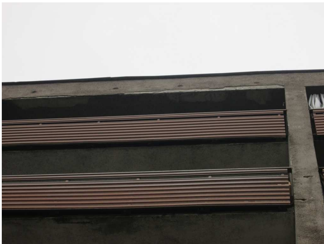
[03.] Poruchy omítky fasády v místě napojení atiky na nosnou konstrukci střešního pláště
