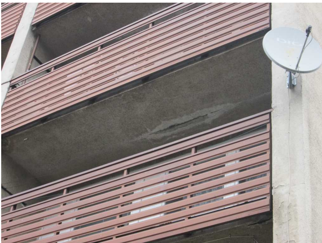
[06.] Poruchy ploše lodžiových desek
