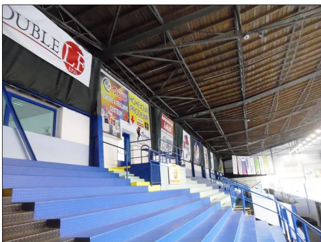
Obr. /5/ Ocelové hlediště, dřevěné bednění ve skladbě střechy
