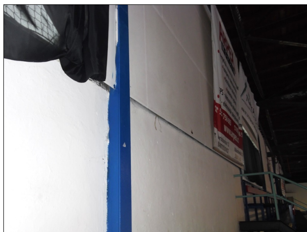
Obr. /6/ Sádkartonový obklad části jedné podélné stěny
